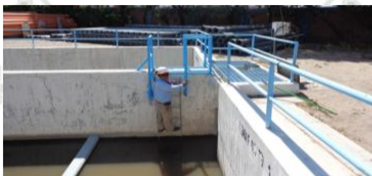
Figura 18: Cámara de Contacto de Cloro
