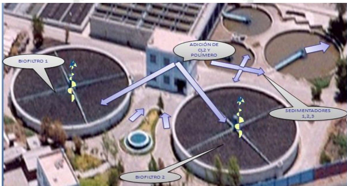
Figura 13: Vista Tratamiento Secundario
