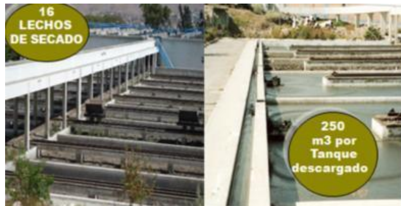
Figura 11: Lechos de Secado
