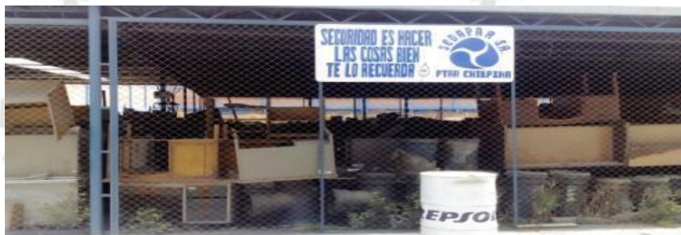
Figura 26: Estado de orden y limpieza en la Planta 1
