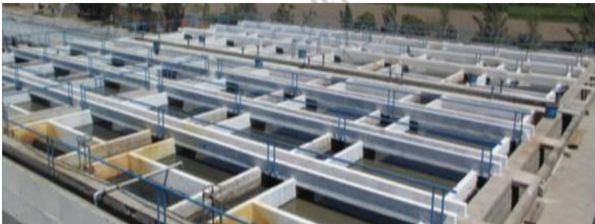
Figura 10: Sedimentadores Horizontales
