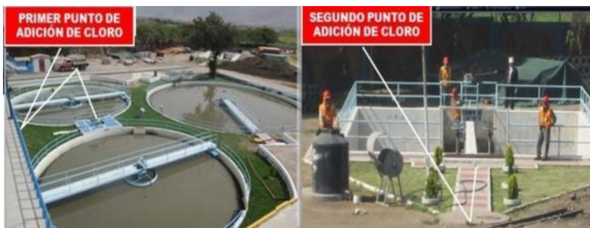
Figura 18: Cámara de Contacto de Cloro
