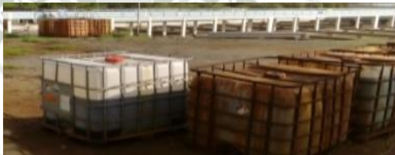
Figura 19: Tanques de Cloruro Férrico
