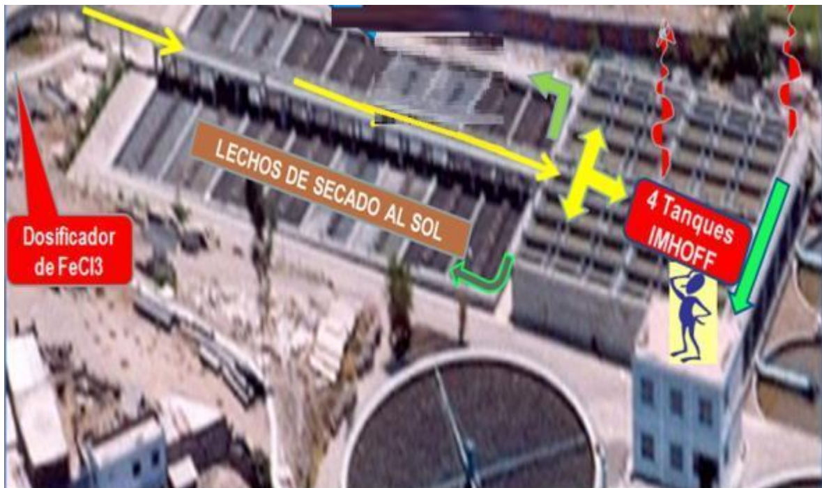
Figura 8: Vista Tratamiento Primario
