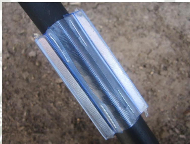
Fotografía 4. Tratamiento magnético del agua de riego en la línea de distribución.
