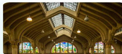
FOTOGRAFIA ESTRUCTURA DE TECHO
