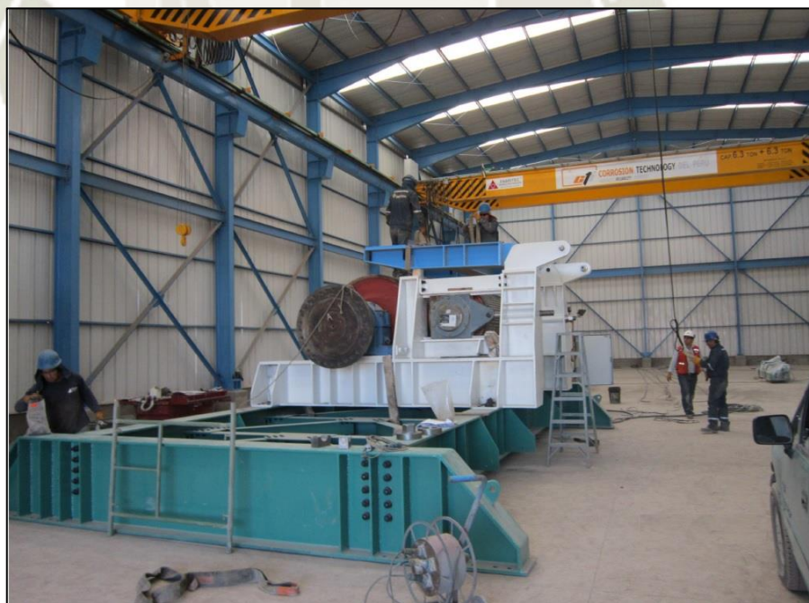
Ilustración 153. Montaje de elementos de fijación para pruebas.
