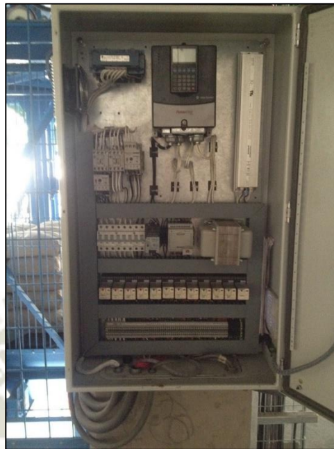
Ilustración 51. Montaje de tablero eléctrico de control.
