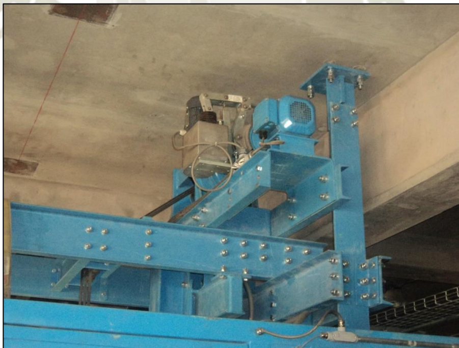
Ilustración 56. Montaje del tren de transmisión
