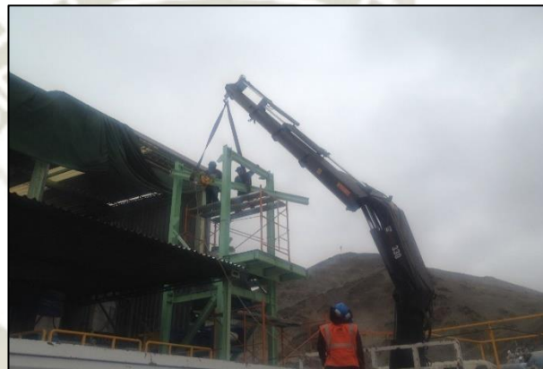
Ilustración 98 Montaje estructural de la planta piloto.
