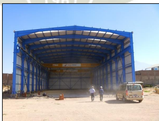
Ilustración 24. Nave industrial con puente grúa.
