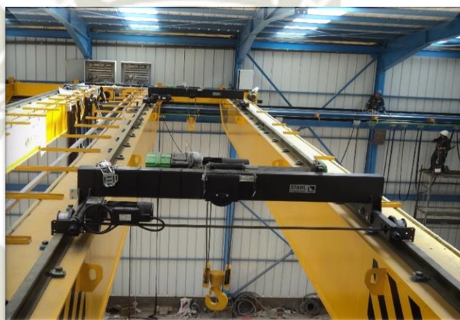
Ilustración 23. Montaje e Instalación de puentes grúa.
