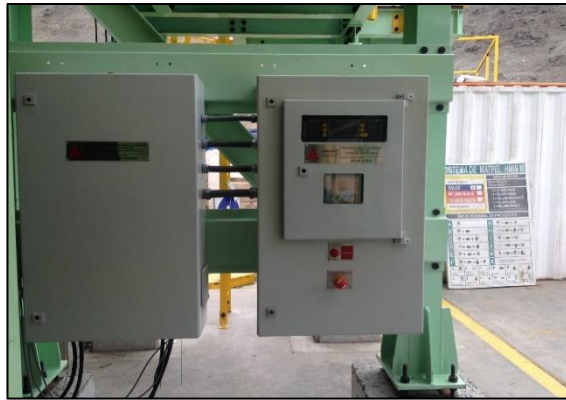
Ilustración 97 Tableros eléctricos después del montaje
