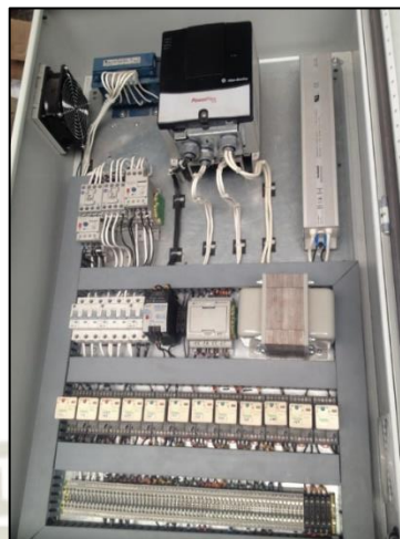
Ilustración 47. Armado de tablero eléctrico de acuerdos a planos.
