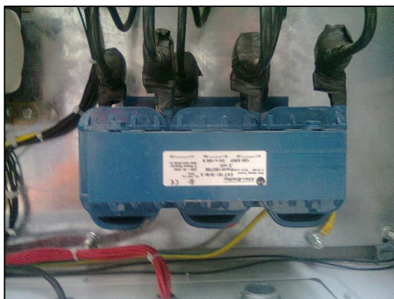
Ilustración 138. Reactancia de Línea.
