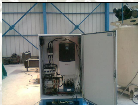
Ilustración 136. Tablero de variación de velocidad terminado.
