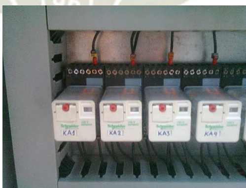
Ilustración 131. Relés de 11 pines Schneider.
