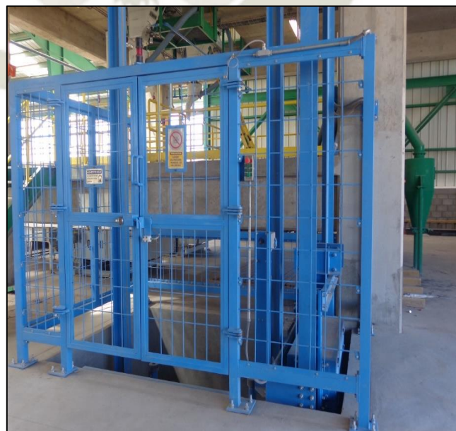
Ilustración 64. Elevador montado primera planta.
