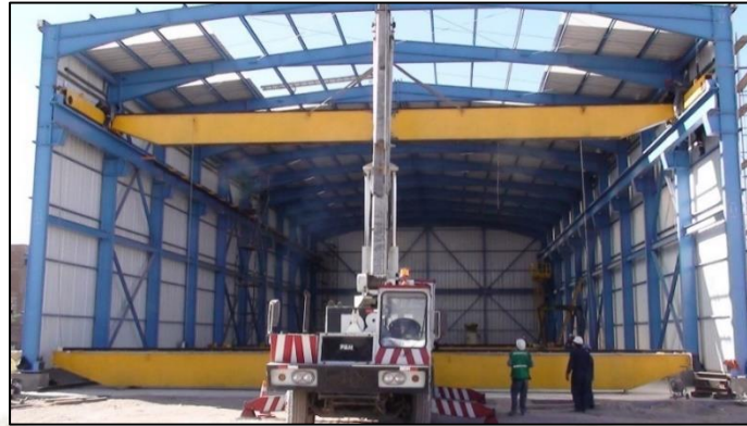
Ilustración 25. Montaje mecánico del puente grúa.
