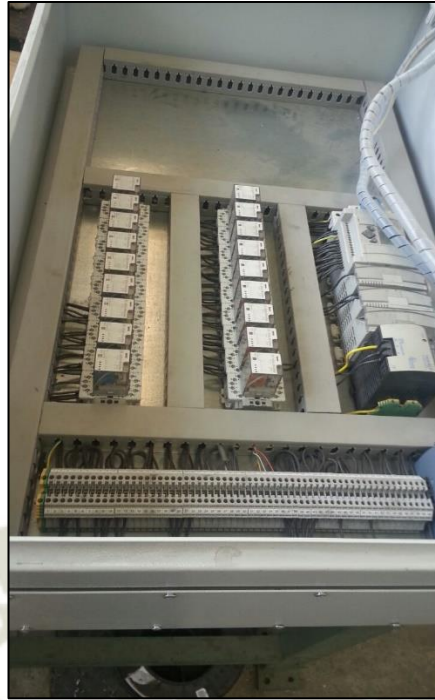
Ilustración 100 Fabricación de tablero de control
