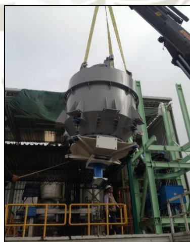
Ilustración 99 Montaje del silo de alimentación
