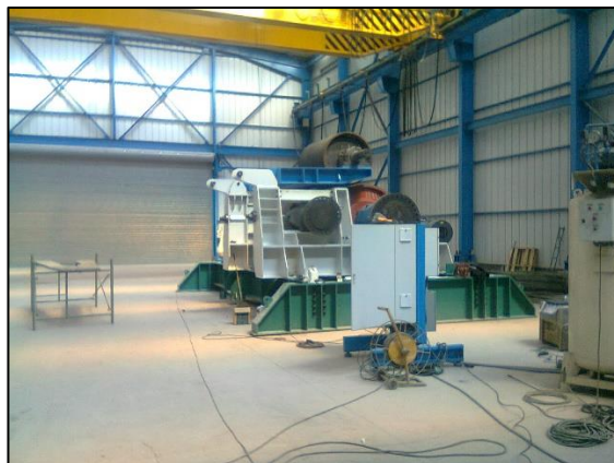
Ilustración 144. Armado de equipo en planta.
