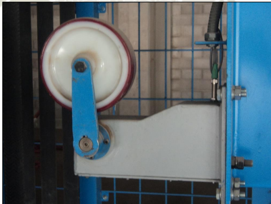
Ilustración 54. Montaje de sensor de baja velocidad.
