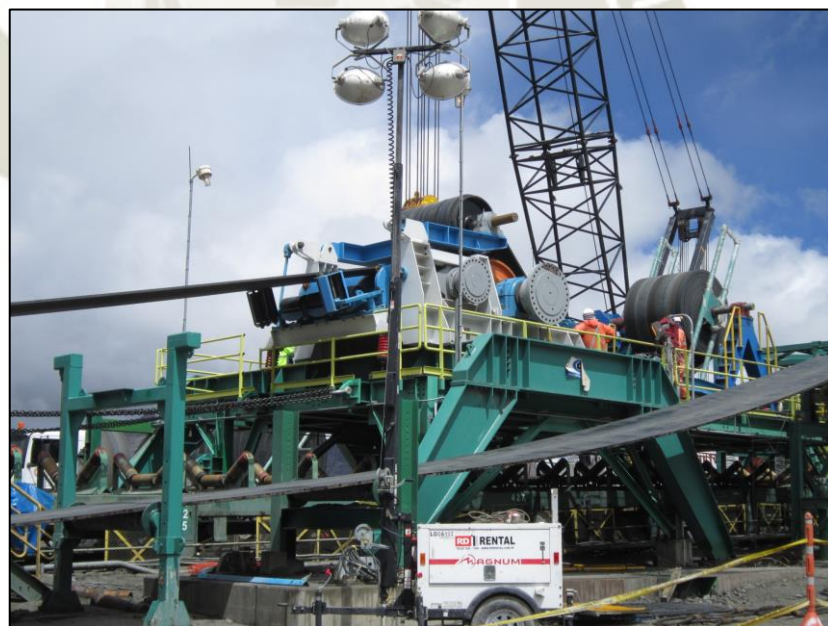
Ilustración 159. Momentos finales de la maniobra de cambio de faja.
