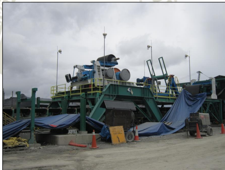
Ilustración 155. Sistema TDS montado en planta concentradora de Antamina.
