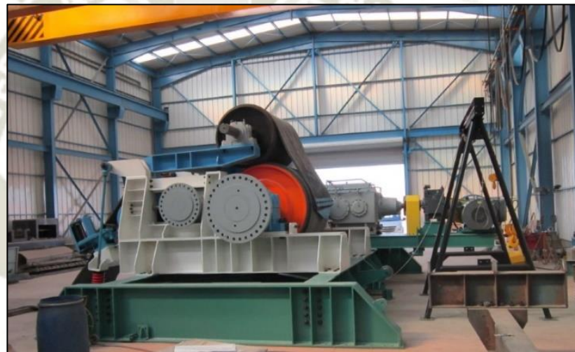
Ilustración 151. Armado de equipo TDS en planta.
