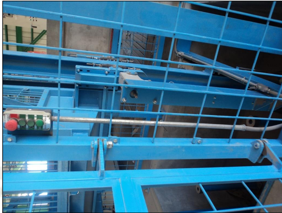
Ilustración 59. Montaje de botonera de accionamiento.
