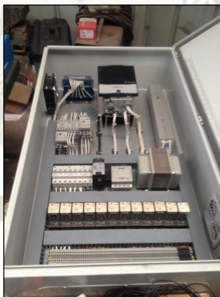
Ilustración 48. Armado de tablero eléctrico de acuerdos a planos II.
