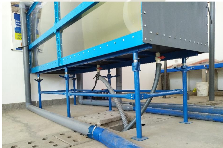
Figura 4-9. Desagüe de la poza de disipación.
