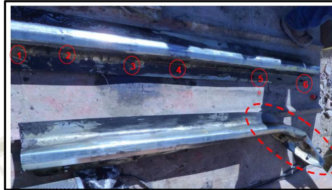
FIGURA 55. Covers dañados y evidencia de rozamiento pala 2160
