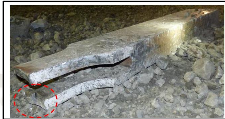
FIGURA 74. Barretón fracturado y zona fatigada pala 2162
