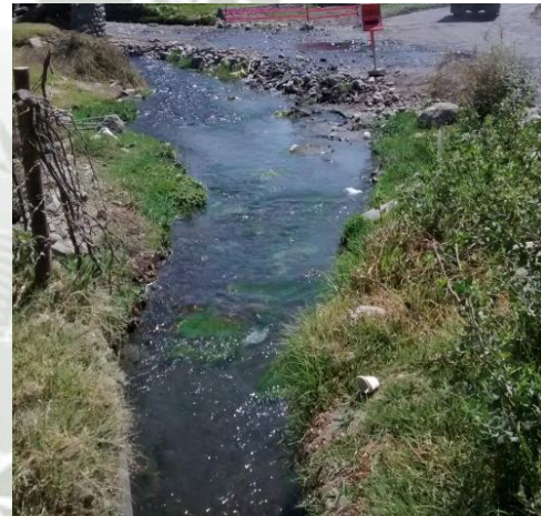
SWA 004 Sabandia, canal de agua
