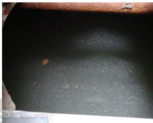
Desagüe a 50 cms. de la superficie
