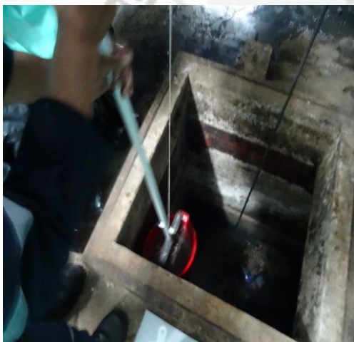
Figura 18. Toma de muestra con balde desagüe del Hospital FAP, LIM
