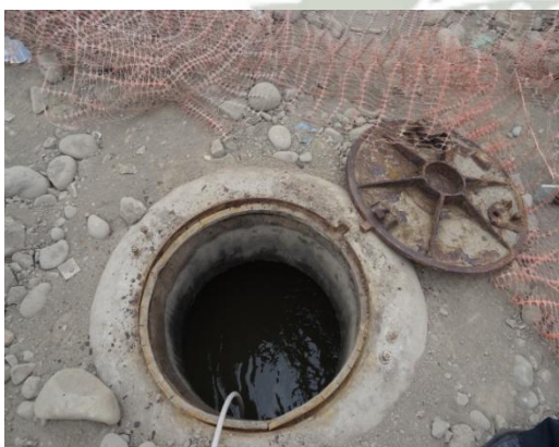
Colector Comas-Chillón. Punto 2
