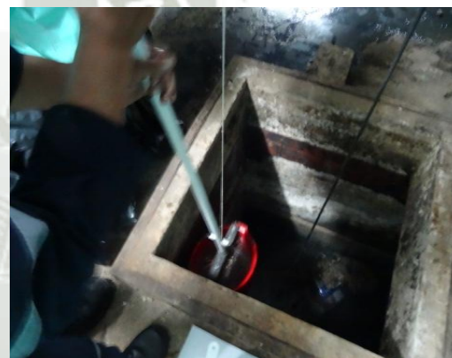
Extracción en balde debido a la distancia de 2 mts. a la superficie del desagüe
