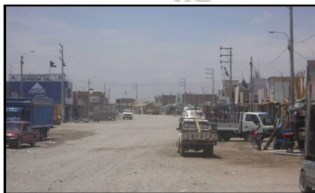
Vista del Sector 04 Modulo A y B del distrito de Majes.
