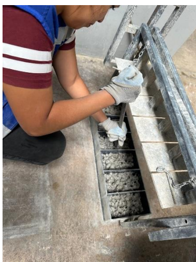
Varillado de concreto
