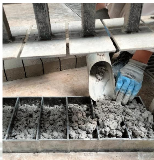
Adición de segunda capa de concreto
