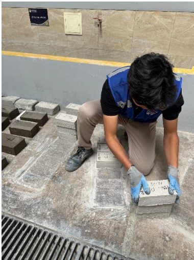
Desmolde de adoquines
