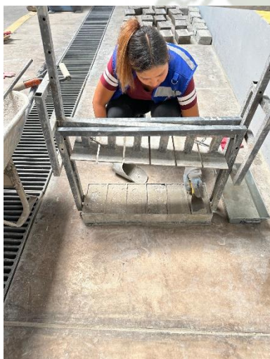
Nivelación de cara frontal de adoquines
