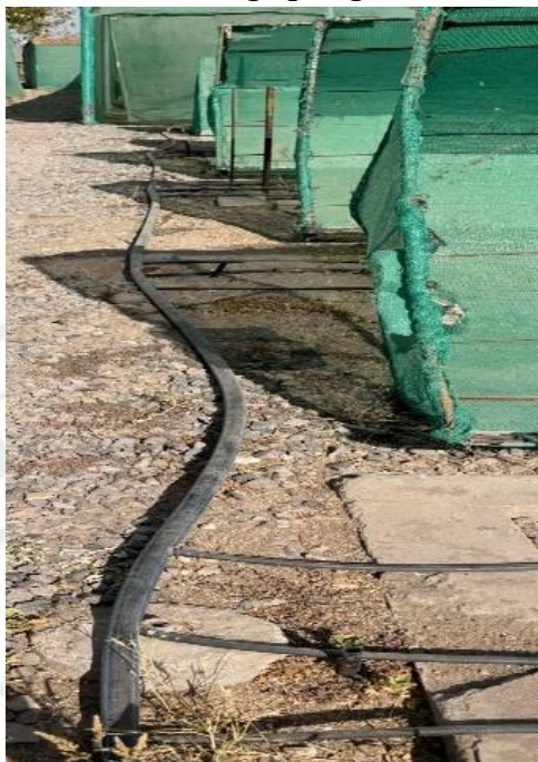
Instalación del sistema de riego por goteo en los micro túneles
