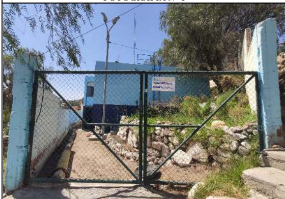
VISTA DE ENTRADA AL RESERVORIO R-20, SABANDÍA.
