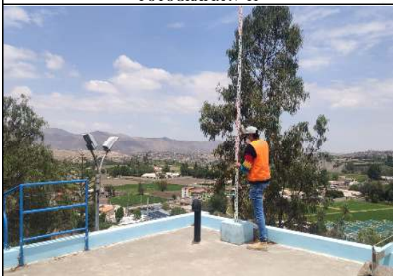
AJUSTE DE ELEVACIONES CON BM AQP 023 PARA CALIBRACIÓN DE TOPOGRAFÍA EN RESERVORIO R-20.
