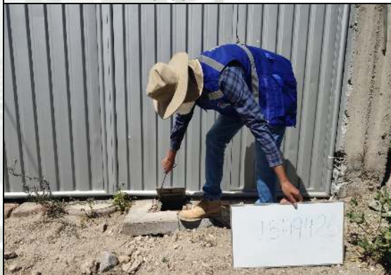
VERIFICACIÓN DE CONEXIONES DOMICILIARIAS CON CONSUMO 0 EN CATASTRO COMERCIAL - SOCABAYA.
