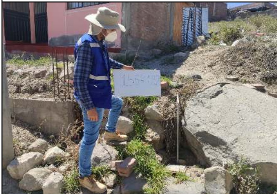
VERIFICACIÓN DE CONEXIONES DOMICILIARIAS EN ZONAS DE ALTA PRESIÓN EN CIRCUITO DEL R-32.
