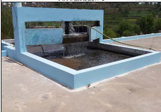
AIREADOR A LA ENTRADA DEL RESERVORIO R-20.
