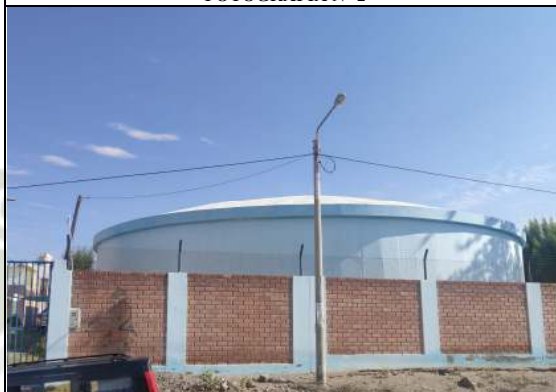
VISTA DE ENTRADA AL RESERVORIO R-32, SOCABAYA.
