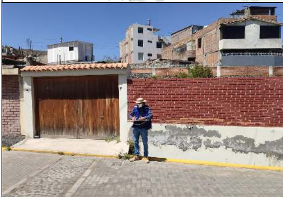
VERIFICACIONES EN CAMPO DE CONEXIONES DOMICILIARIAS - SABANDÍA.
