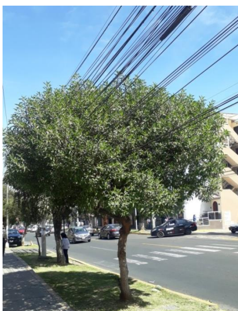
Foto 23: Redes aéreas en contacto con arboles A
