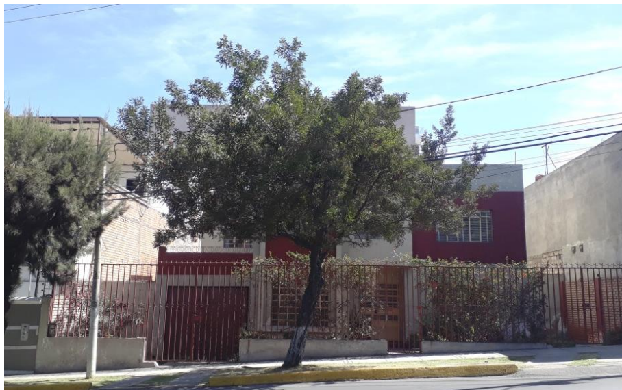
Foto 24: Redes aéreas en contacto con árboles B
