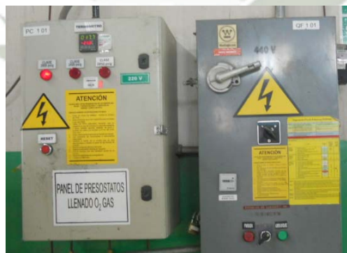
Grafica N~39: Presostato y Medidor de Temperatura
