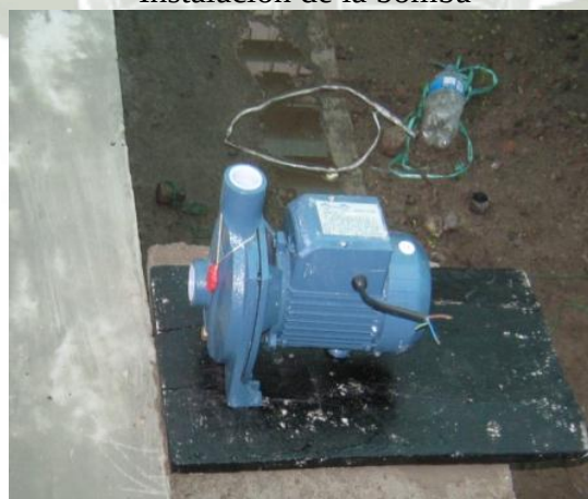
Fotografía N°21 Instalación de la bomba
