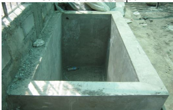
Fotografía N°14 Construcción del tanque
