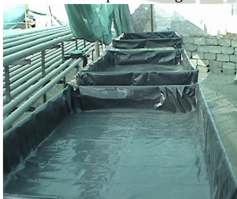
Fotografía N°33 Colocación plástico negro
