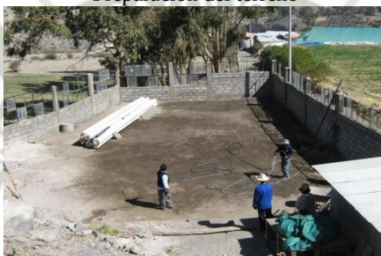
Fotografía N°13 Preparación del terreno
