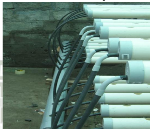
Fotografía N°23 Colocación de las mangueras
