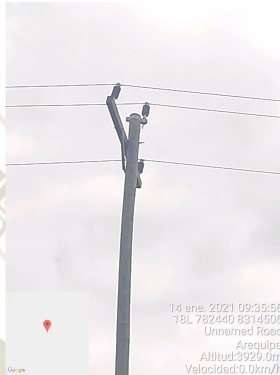
Figura N° 48. Poste de pino tratado de 13 metros usados en el sistema interconectado.
