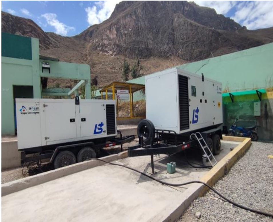
Figura N° 53. Instalación de Grupos electrógenos AREM
