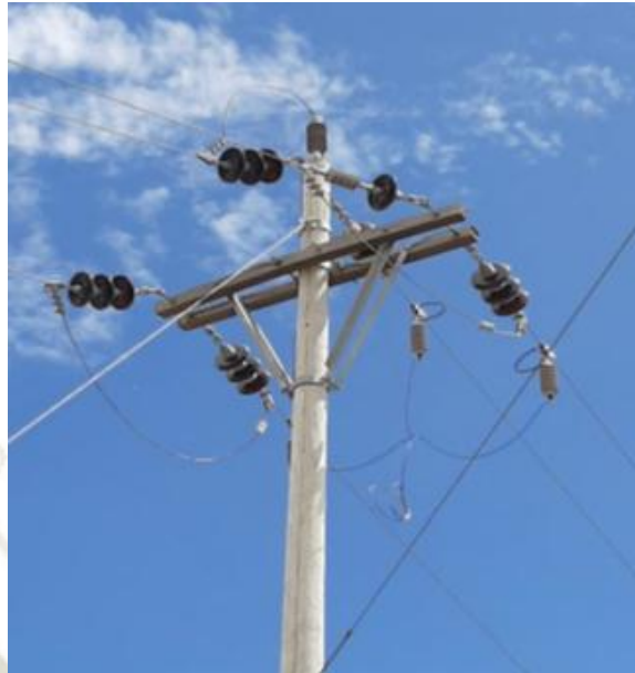
Figura N° 65. Redes de distribución con Pararrayos de Línea
