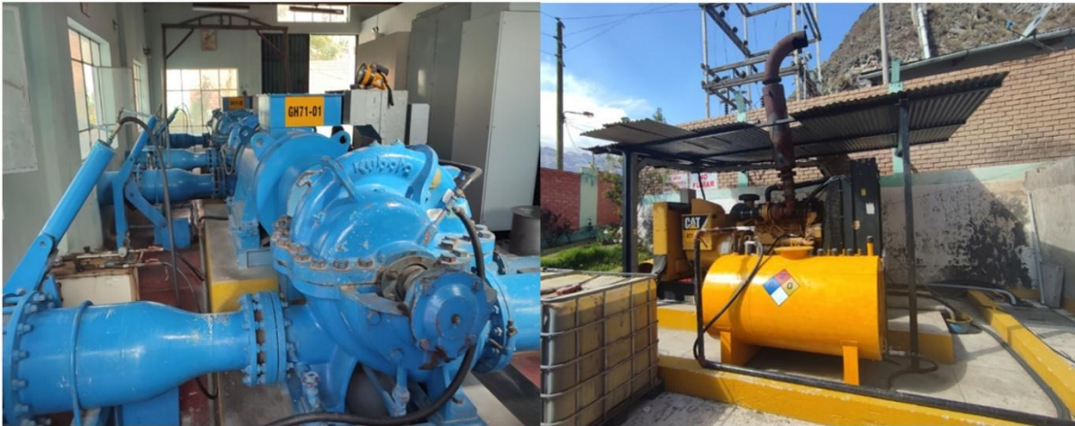
Figura N° 52. Instalaciones de Grupo Electrónico CATERPILLAR.
