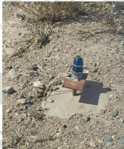
Figura 35: Equipo de luz de calle de rodaje
