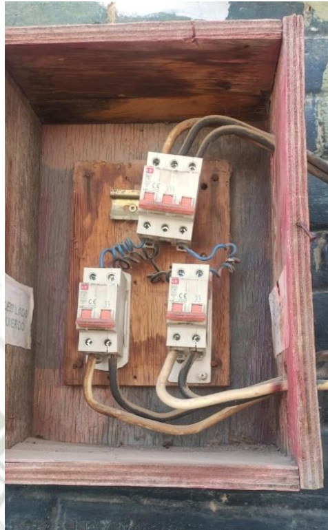
Figura 37: Tablero eléctrico del sistema de iluminación de la pista
