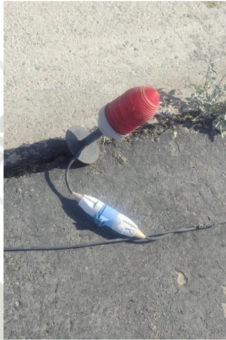
Figura 36: Equipo de luz de extremo de pista
