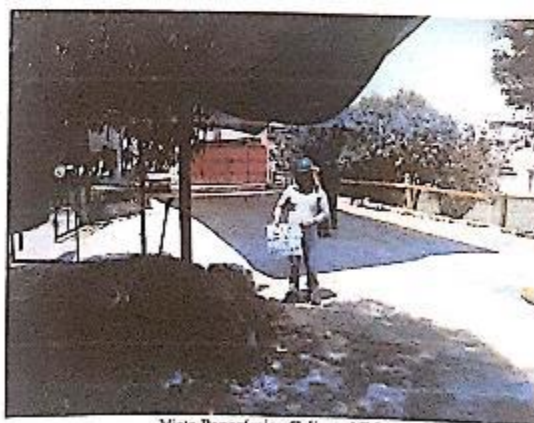
Vista Panorámica Calicata N° 2 Fotografía N° 4
