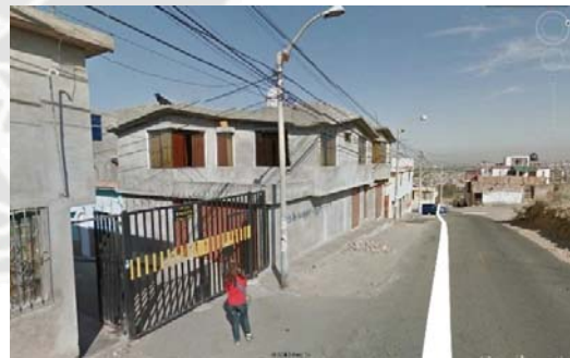
Figura 67: Segregación Social debido al uso de rejas. Fuente: google earth.
