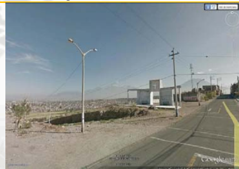
Figura 12: Estructura Inconclusa de iglesia, sector sur del terreno. Fuente Google Earth.
