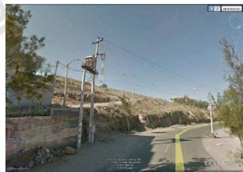
Figura 55: Típico terreno Rocoso presente en la zona de intervención, Fuente Google Earth.
