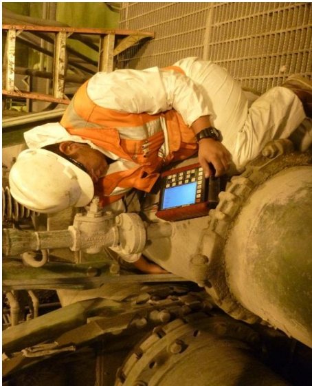
Fig. 6.25. Inspección 4 Fuente: Southern Perú Cooper Corporation
