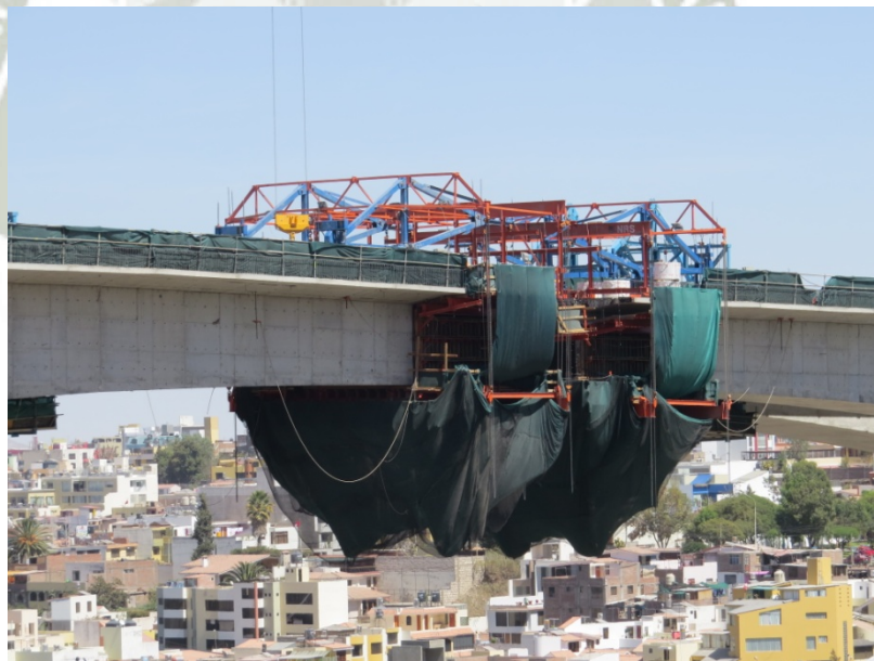
Foto 11: Fuente Archivo Fotográfico P. Chilina – Dovela de Cierre.
