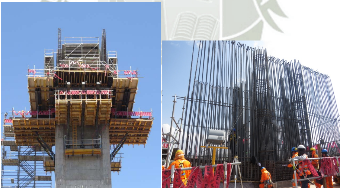
Foto 02: Fuente Archivo Fotográfico P. Chilina – P 03: Consolas, Plataformas de trabajo y Colocación de Acero
