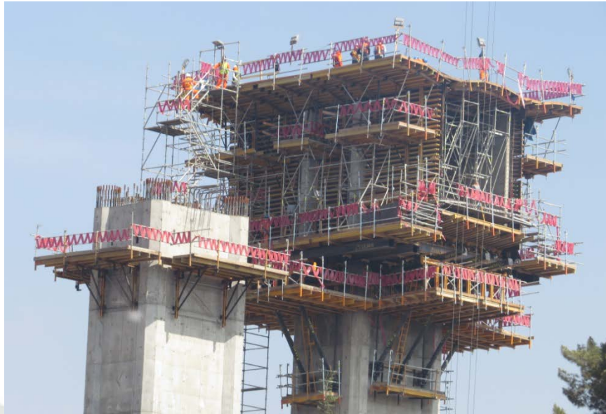
Foto 03: Fuente Arch. Fotográfico P. Chilina – Encofrado Completo Losa Sup.
