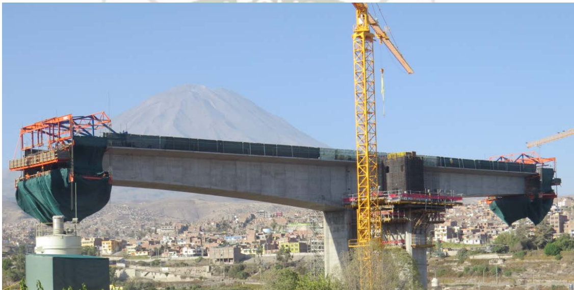
Foto 01: Fuente propia – Pilar 03: Voladizos Sucesivos con Carro de Avance NRS (Puente Chilina, Arequipa-Perú)
