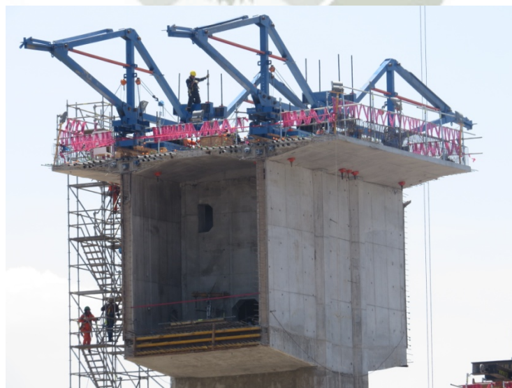
Foto 05: Fuente Propia – Montaje de Marcos Principales.
