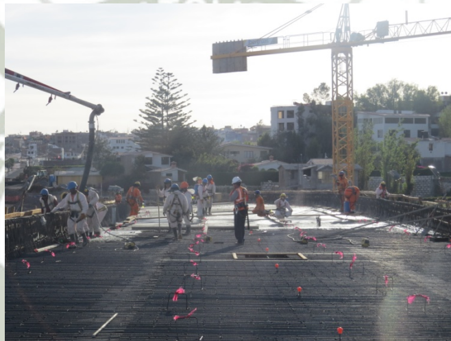
Foto 15: Fuente propia – Colocación de concreto en losa sup. de viga cajón.
