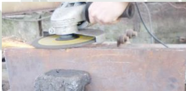
Figura 3-27: Limpieza de las rebabas utilizando un esmeril de mano con disco de desbaste acoplado Fuente: Elaboración propia
