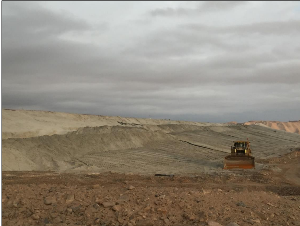
Tractor D8T CAT trabajando en un cancha de relave húmedo
