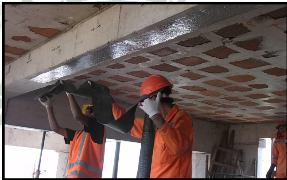
Figura 6.20 Colocación de SIKAWRAP-600C en la viga V-10.
