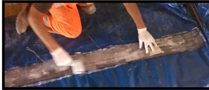
Figura 6.19 Aplicación de SIKADUR-301 en la fibra.
