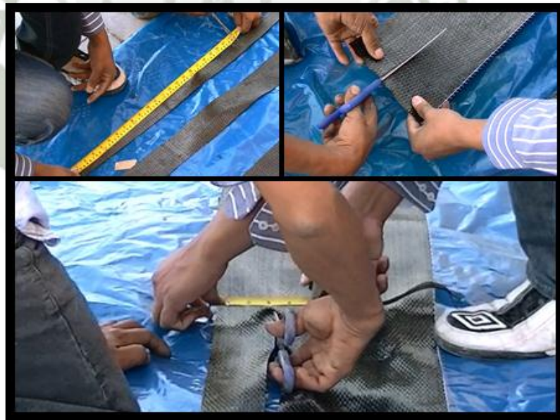
Figura 4.39 Habilitación de la fibra de carbono.
