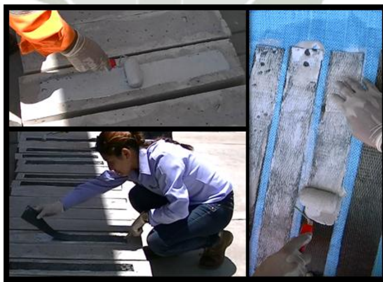
Figura 4.41 Aplicación y colocación de productos SIKA.
