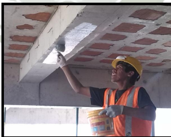
Figura 6.18 Aplicación de SIKADUR-301 en la viga.
