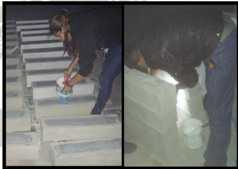
Figura 4.44. Pintado lateral de las vigas.
