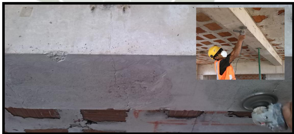
Figura 6.15 Pulido de viga V-10
