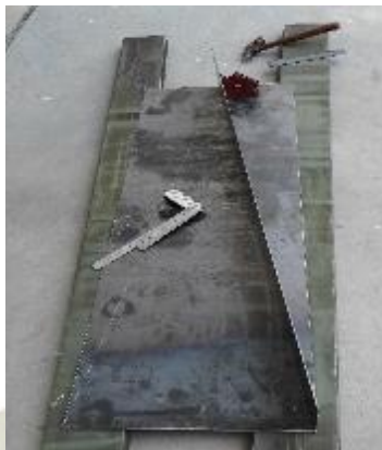
Fotografía 16. Trazo y soldadura de plancha metálica para vertederos
