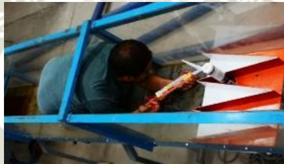
Fotografía 23. Habilitación de vertedero en canal hidrodinámico
