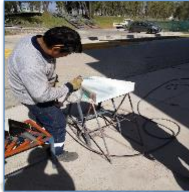
Fotografía 19. Pintado de vertedero
