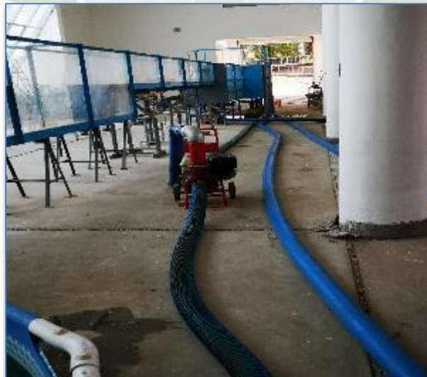
Fotografía 9. Tuberías y mangueras de alimentación
