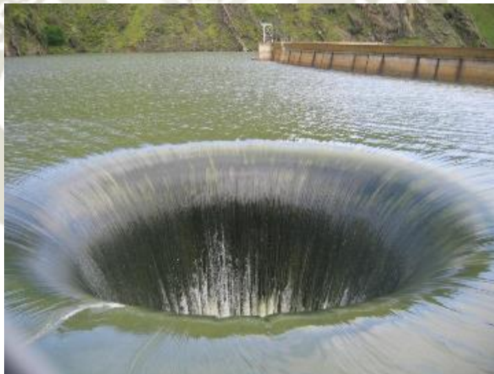
Figura 22 Aliviadero tipo Morning Glory de la presa de Monticello
