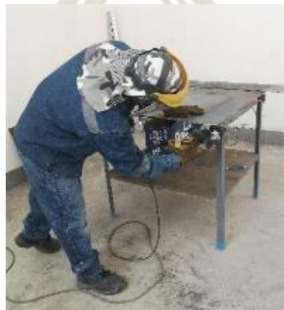
Fotografía 15. Pulido de planchas metálicas
