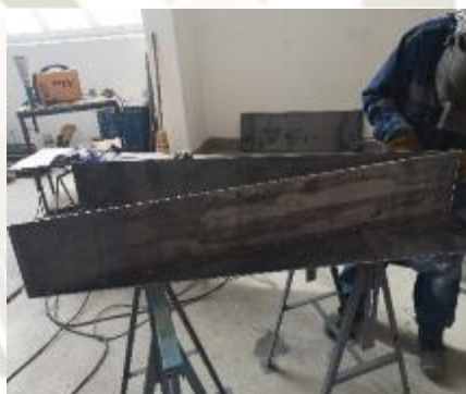
Fotografía 17. Soldadura de paredes del vertedero
