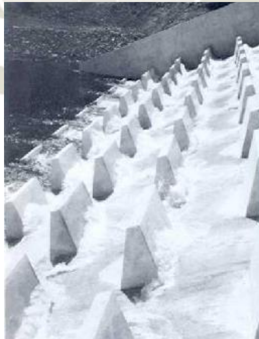
Figura 19 Vertedero dentado en la presa de Cobconully, Washintong Fuente: (BUREAU OF RECLAMATION & Elgin Dominy, 1966)
