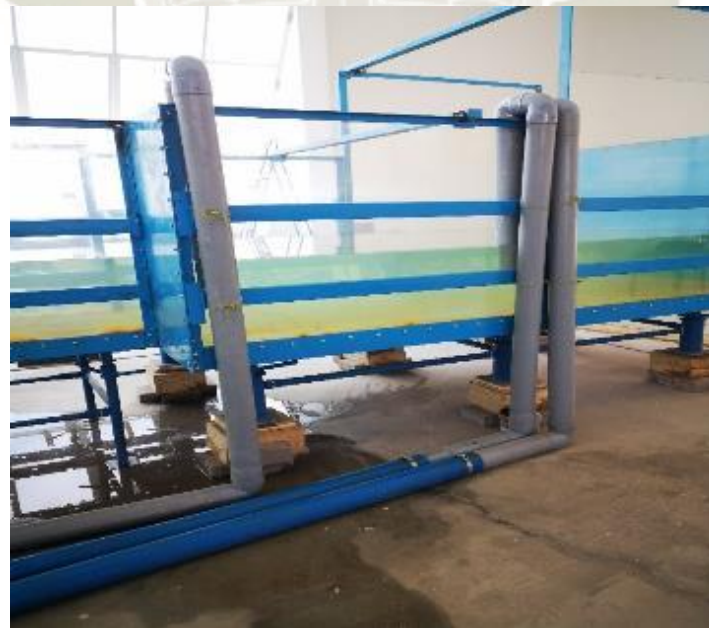
Fotografía 4. Tuberías de alimentación a la poza de disipación
