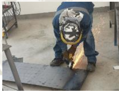
Fotografía 14. Corte de planchas metálicas a medida para vertederos
