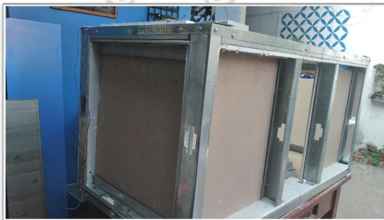
Fotografía 7: Plegado de planchas de Yeso.
