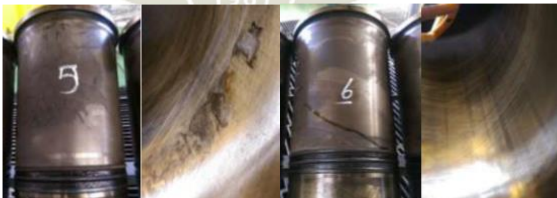
Imagen N° 67: Manchas de agua y desgaste abrasivo en camisas
