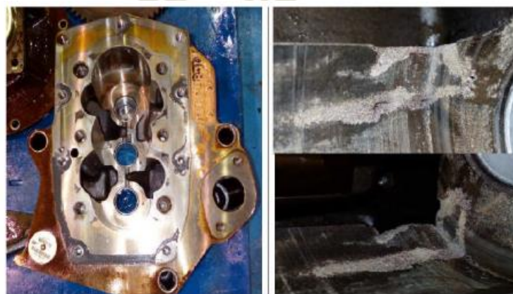
Imagen N° 85: Erosión por cavitación en cuerpo de la bomba
