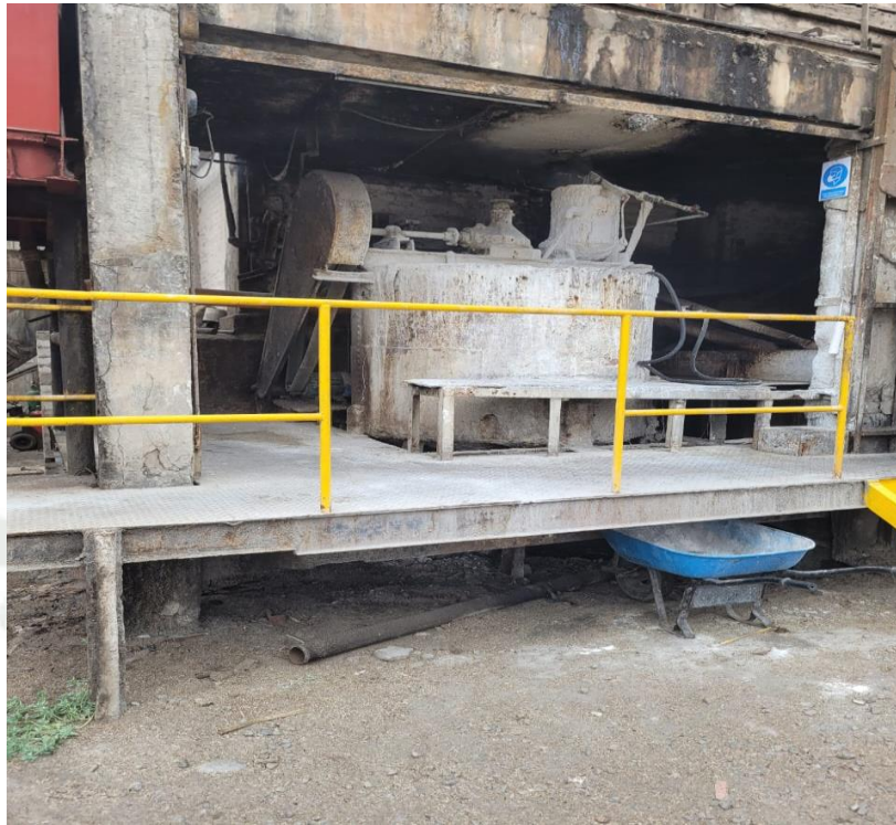
Figura 11 Imagen de la zona de encalamiento proceso de clarificación
