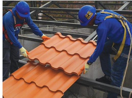
FOTO 59 - Instalación de tejas – Fuente: Eternit
