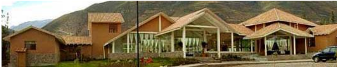
FOTO 12 - Fachada principal del Hotel Casa Andina
