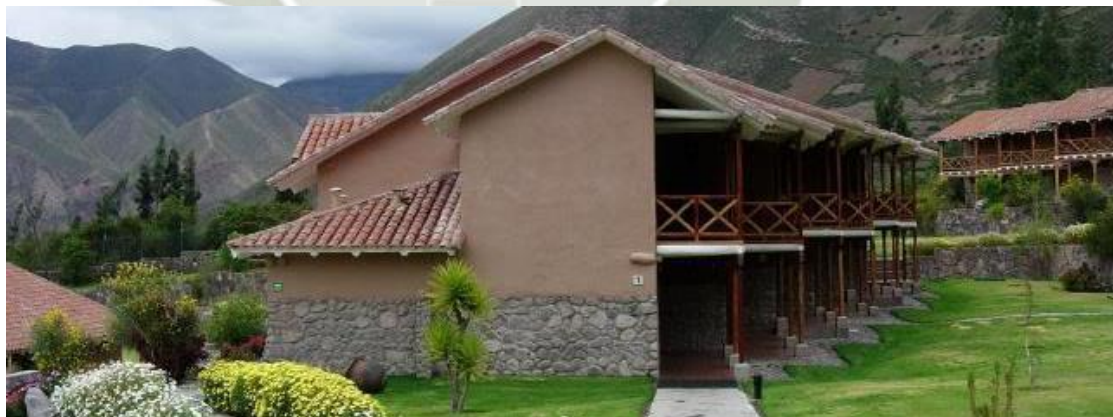
FOTO 15 - Muro de piedra y adobe, techos de teja de cerámica y balcones en madera rolliza.
