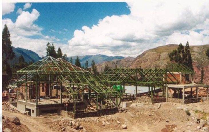
FOTO 16 - Estructura metálica del sector de recepción y usos múltiples.
