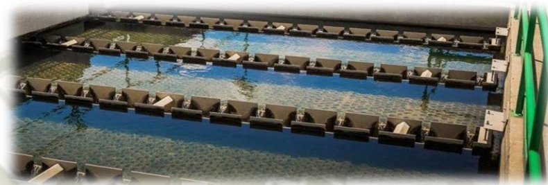
FIGURA 1.2: DECANTADOR DE LECHO DE FANGOS, TIPO PULSADOR
