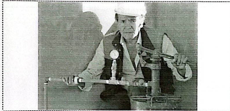
FOTO N° 08 del 11.09.2014.- Supervisor verificando la realización de la prueba de presión de agua en las tuberías de agua fría de las Pañoleras.
