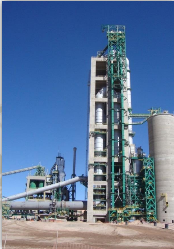
Figura 14 Intercambiador de Calor
