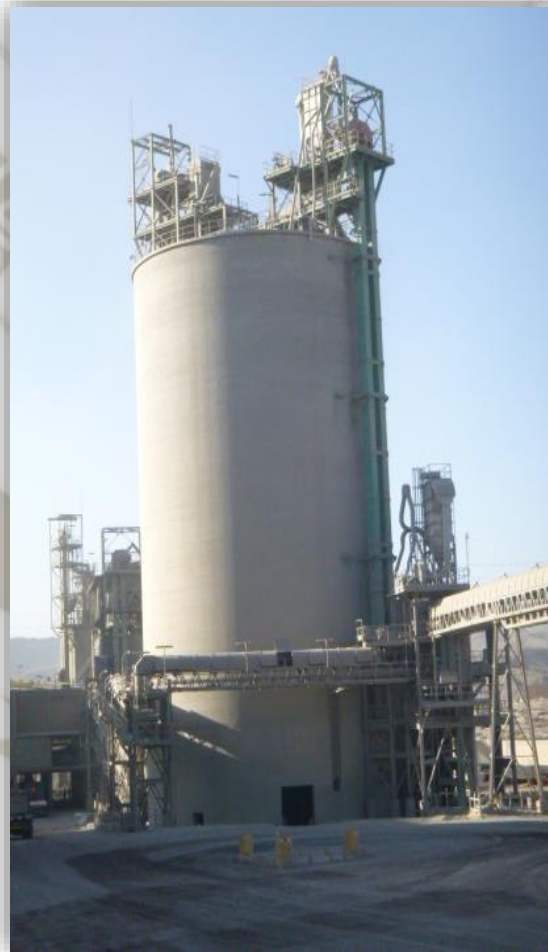
Figura 23 Silo de Almacenamiento
