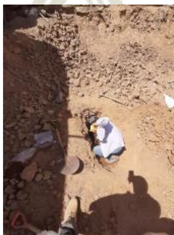
Fotografía 3, Excavación de calicata
