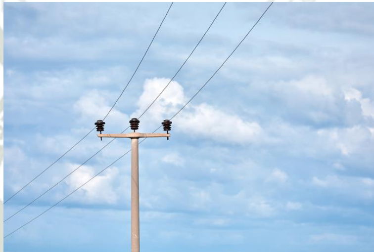
Figura 25: Poste de concreto u hormigón
