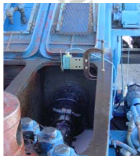
Figura 151. Sensor de Cuenta Emboladas Instalado en Pistón de Bombas.
