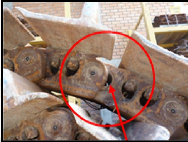
Figura 40: Desgaste interno excesivo por junta seca.
