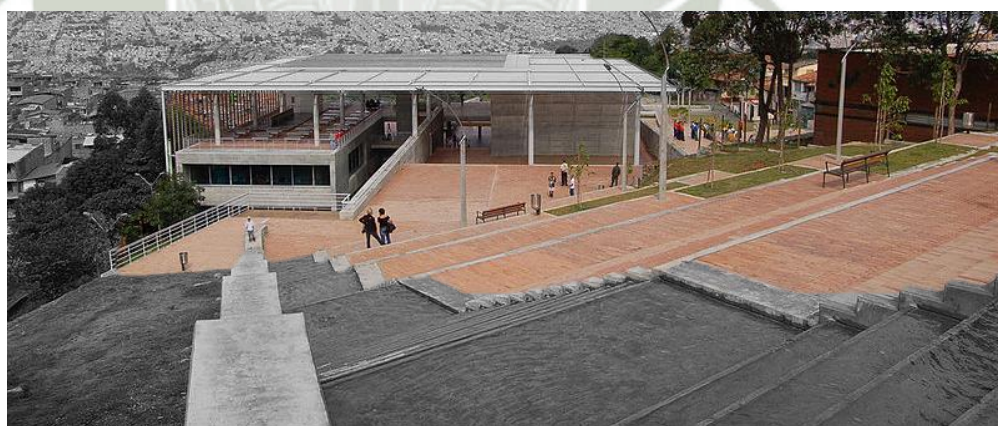
Figura 43. Biblioteca Tomas Carrasquilla-la Quintana en Medellín, ejemplo de la percepción de y la percepción desde... Tomada de “Red de Bibliotecas, Fundación EPM” 2008. Recuperado de: http://www.reddebibliotecas.org.co/grupos/sbpm
