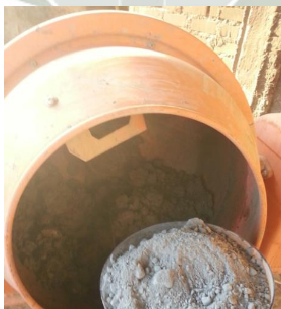
Ilustración 15: Mezclado del concreto
