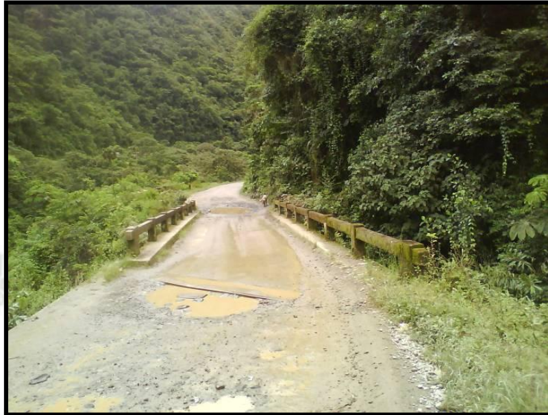
Figura 28. Km.139+690, Puente Machente
