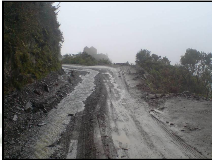
Figura 22. Vista panorámica Km 100+100
