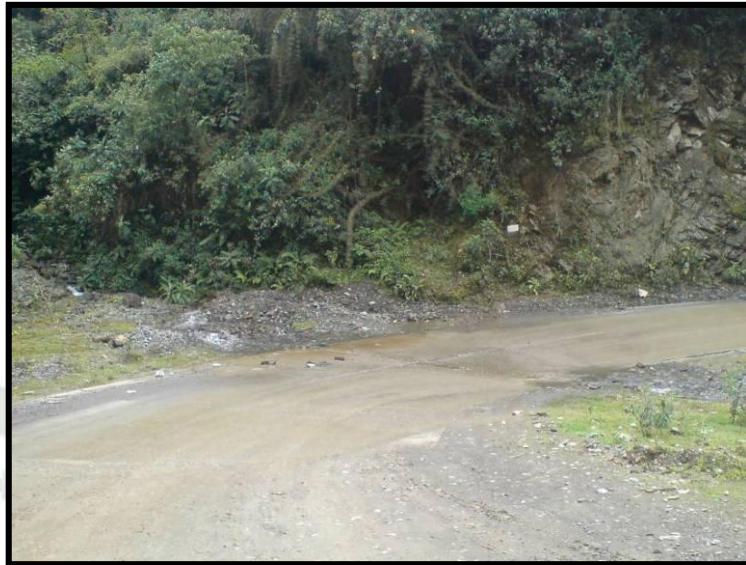
Figura 26. Km.105+680, cruce importante de curso de agua y existencia de badén de concreto.
