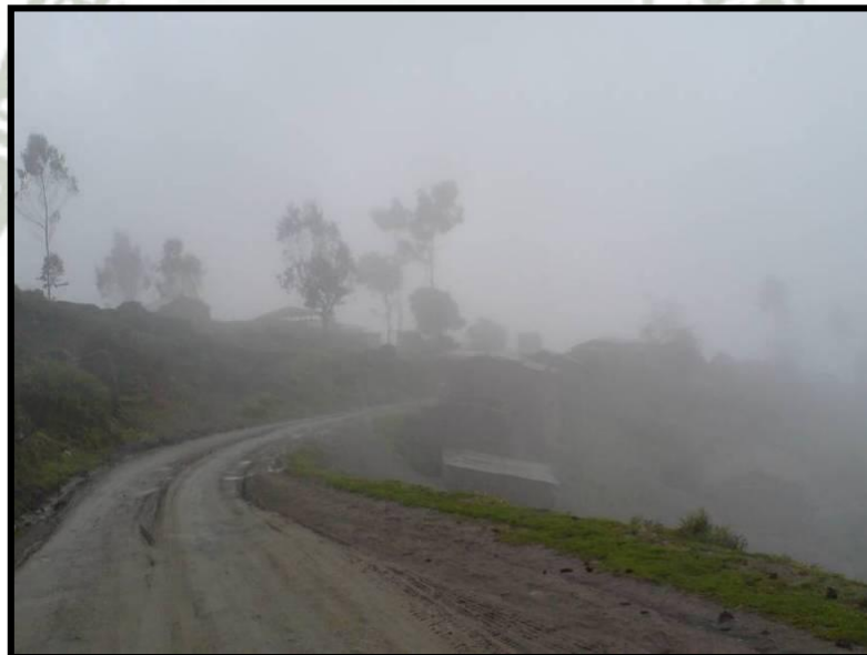
Figura 20. Vista panorámica Km. 96+200, entrada al poblado de Panty
