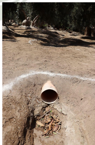
Canales de regadío del fundo
