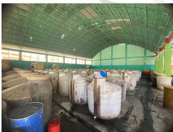
Área de almacenaje de aceitunas para su proceso de fermentación
