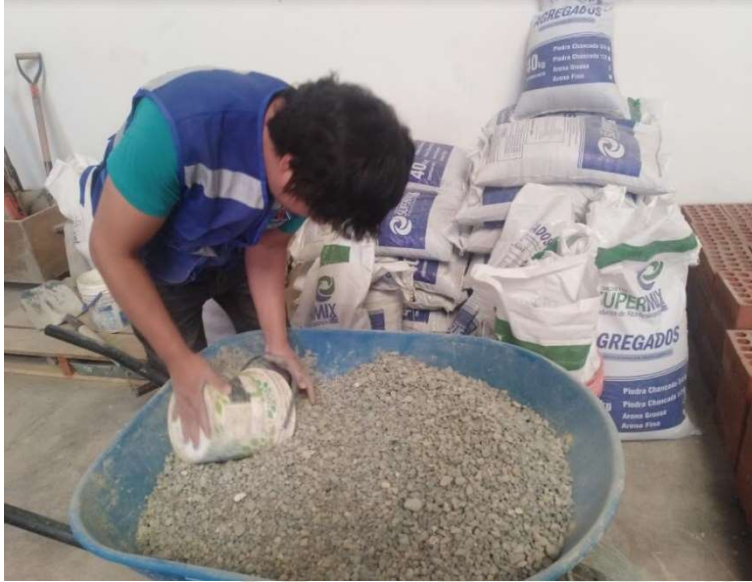
Ilustración 3 Mezcla de agregados
