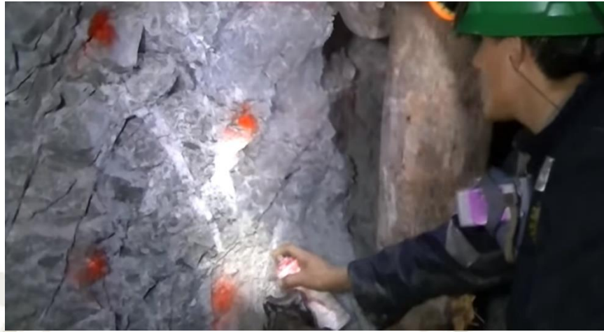
Foto 4 Marcado de malla de perforación Fuente: Elaboración propia
