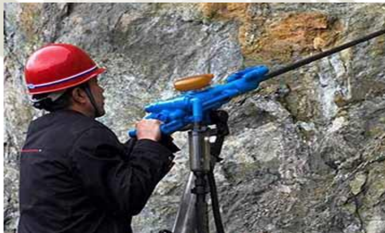
Foto 5 Proceso de perforación Fuente: Elaboración propia
