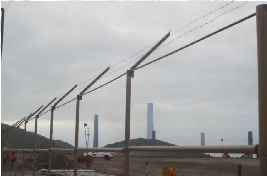
Fotografía 4 Montaje de cerco perimétrico
