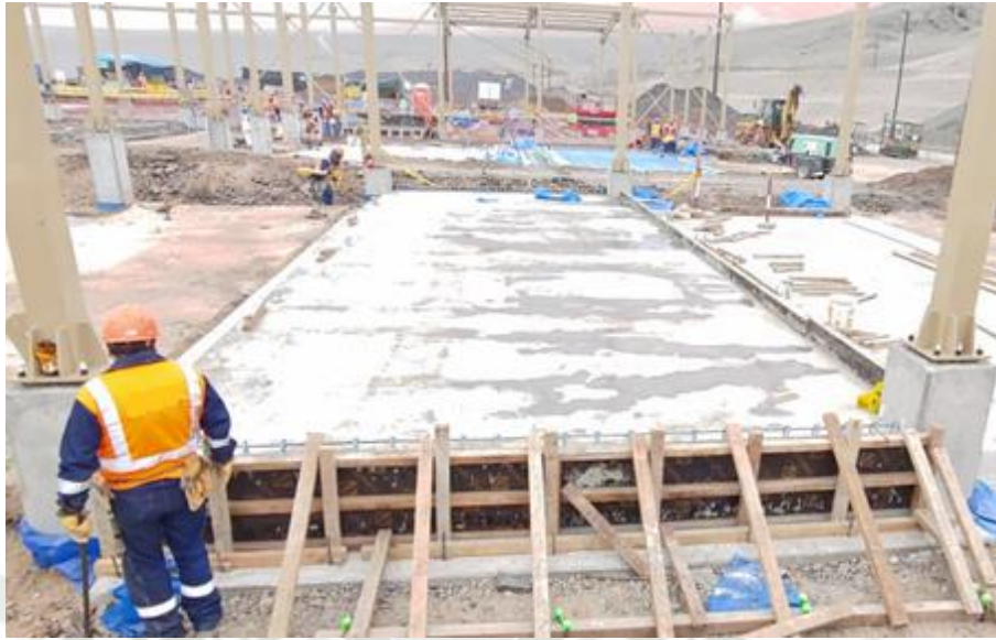
Fotografía 1 Vaciado de losas
