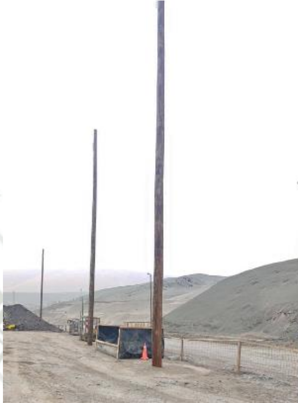
Fotografía 9 Izaje de postes de iluminación
