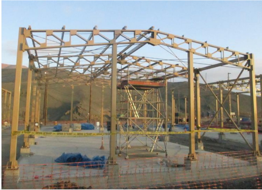
Fotografía 11 Montaje de estructuras metálicas
