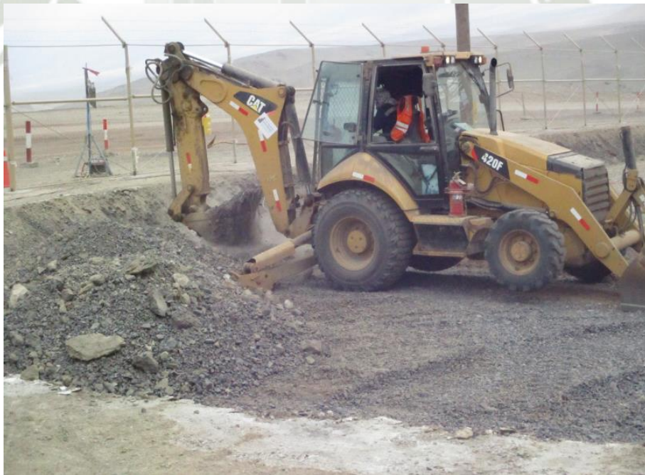
Fotografía 16 Excavación de terreno, movimiento de tierra
