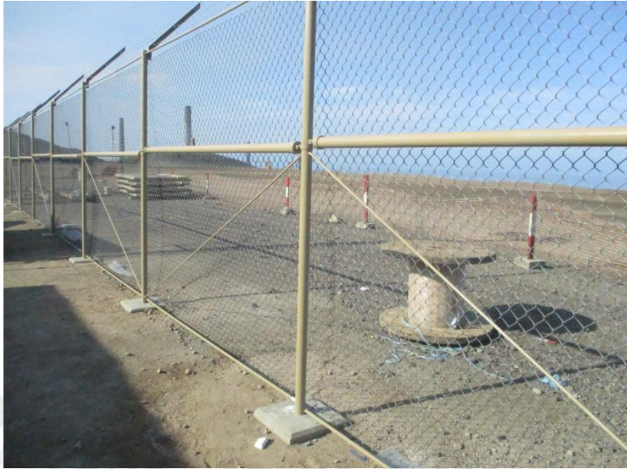
Fotografía 13 Colocación de malla en cerco perimétrico
