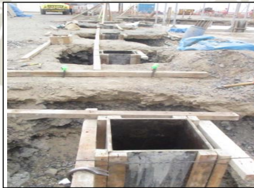
Foto 05- Encofrado de pedestales de cerco perimétrico
