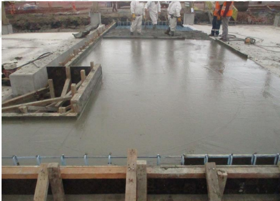
Fotografía 12 Vaciado de losas
