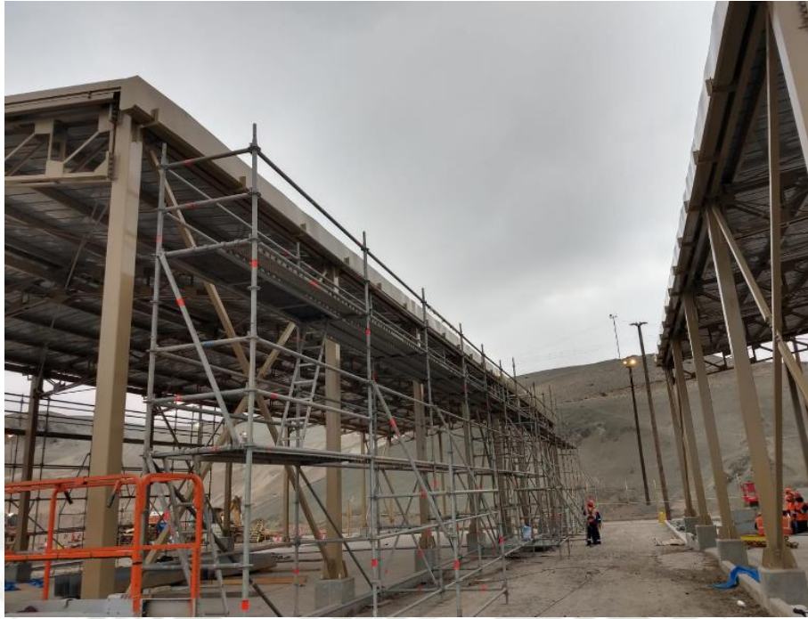
Fotografía 15 Instalación de canaletas pluviales
