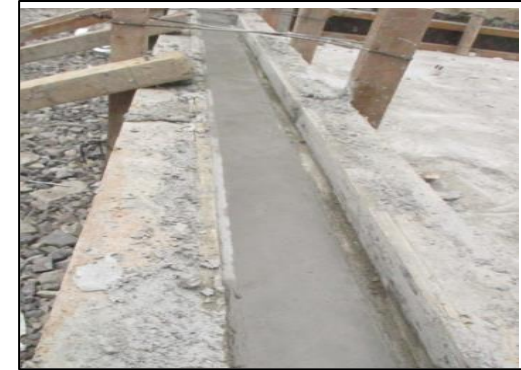
Foto 03- Vaciado de sardinel de losa 2
