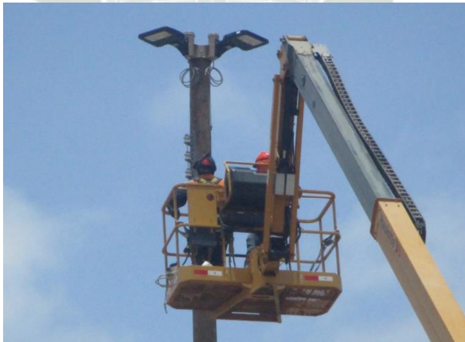
Fotografía 10 Instalación de luminarias para iluminación
