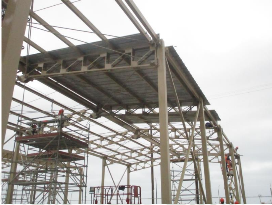
Fotografía 3 Montaje de coberturas
