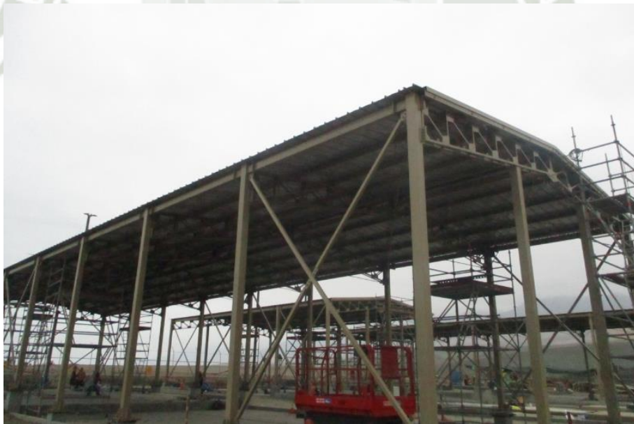
Fotografía 14 Montaje de coberturas metálicas
