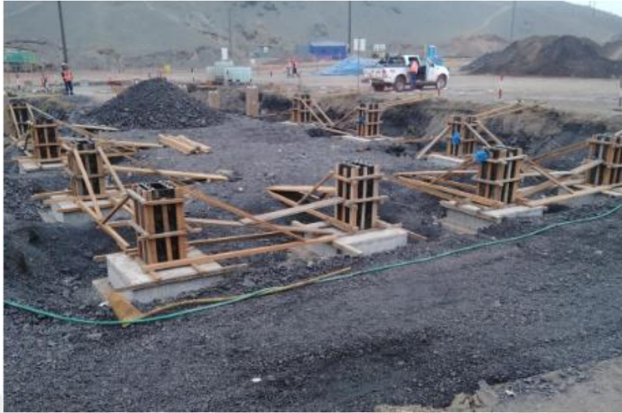
Fotografía 5 Trabajos de cimentación, vaciado de zapatas, encofrado de pedestales
