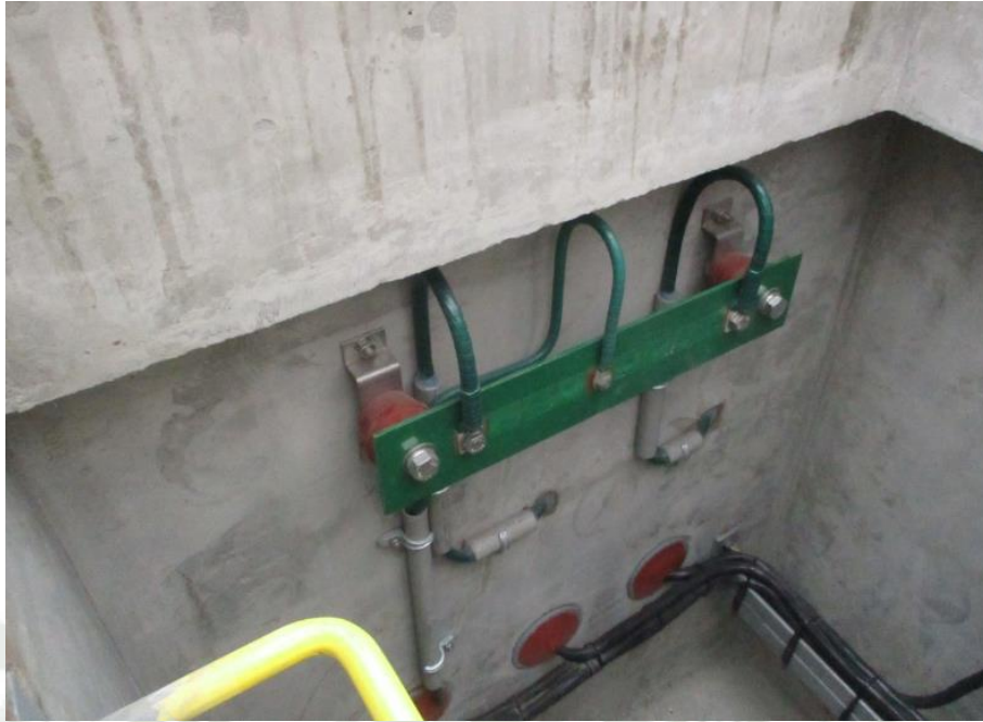
Fotografía 17 Trabajos eléctricos en manholes
