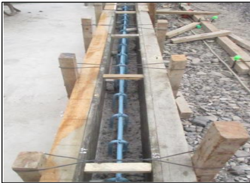
Foto 04- Encofrado de sardinel de losa 3
