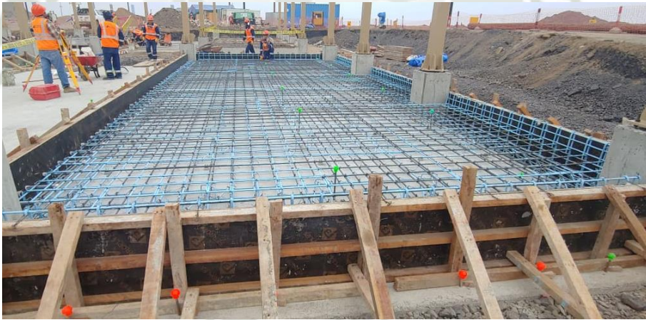
Fotografía 6 Colocación de acero y encofrado de losas
