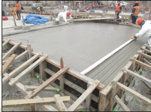
Foto 02- Vaciado de rampa de losa 2
