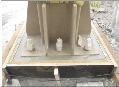
Foto 01- Vaciado de grout en pedestales de losa 1
