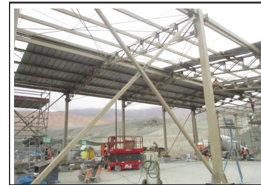
Foto 06 – Montaje de coberturas en losa 1
