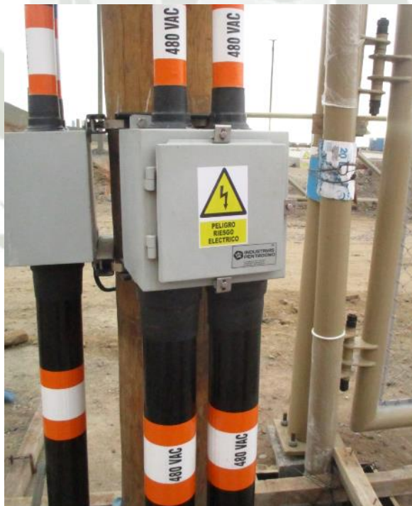
Fotografía 19 Instalación de cajas de paso y tuberías eléctricas
