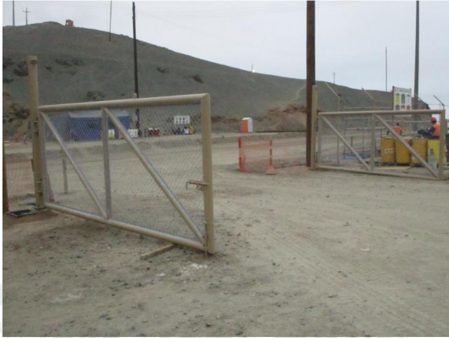
Fotografía 20 Montaje de portón metálico
