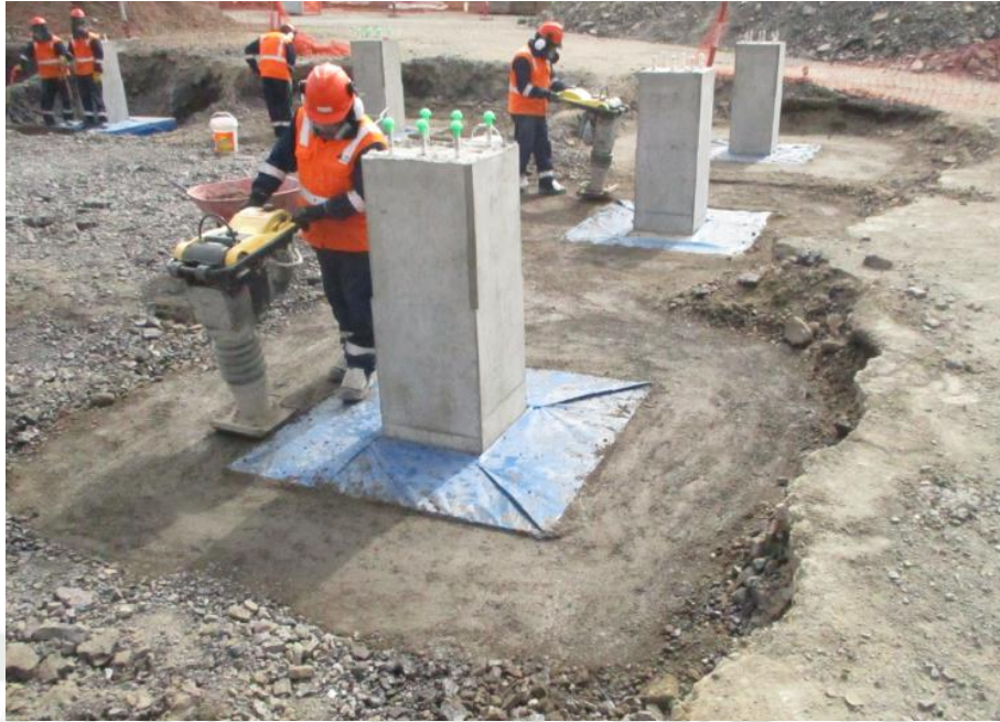
Fotografía 7 Trabajos de cimentación, relleno costado de zapatas
