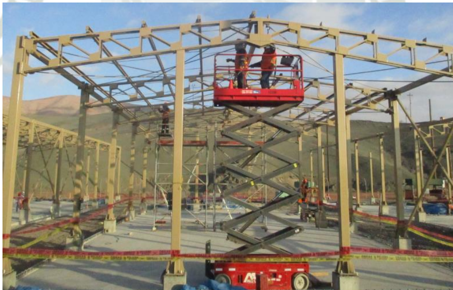
Fotografía 8 Montaje de estructuras metálicas
