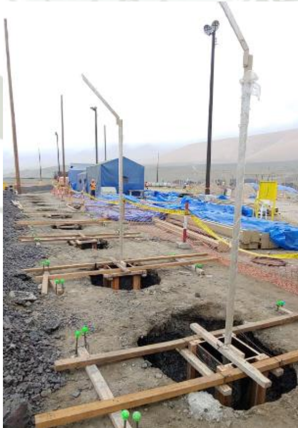
Fotografía 2 Colocación de cerco perimétrico
