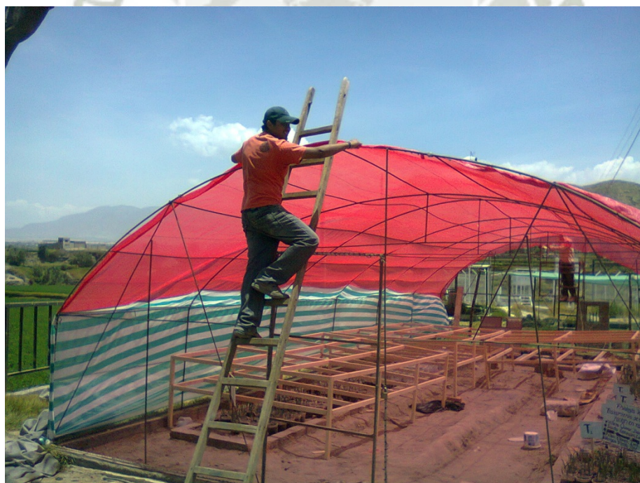
FOTOGRAFIA No.03 Rehabilitación Invernadero Tipo Túnel
