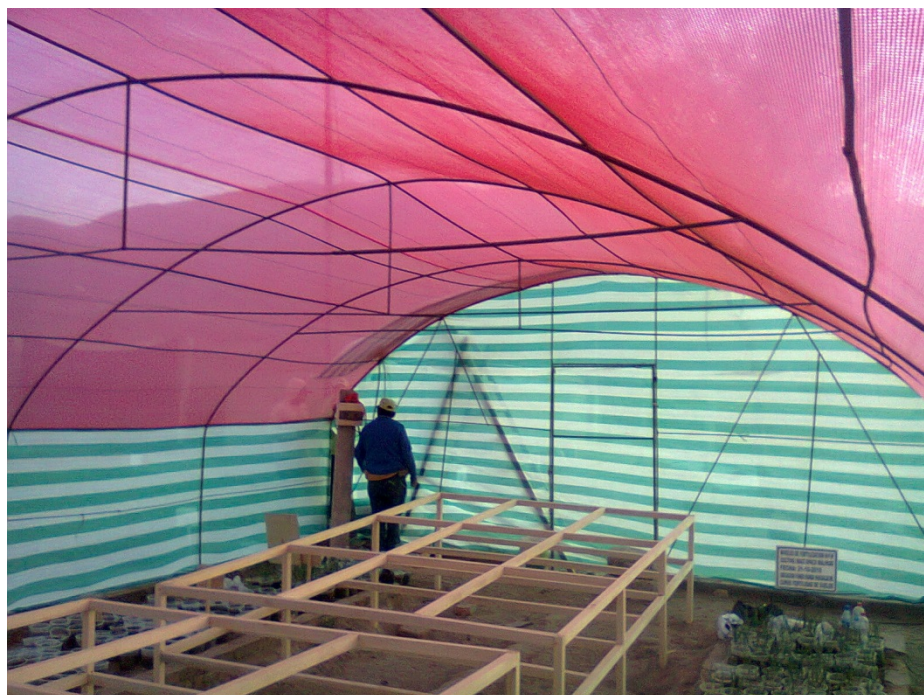
FOTOGRAFIA No. 04 Invernadero Tipo Túnel rehabilitado
