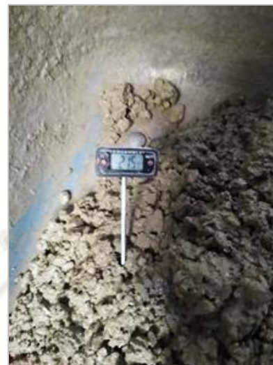
Figura 2.25. Tomando la temperatura al concreto
