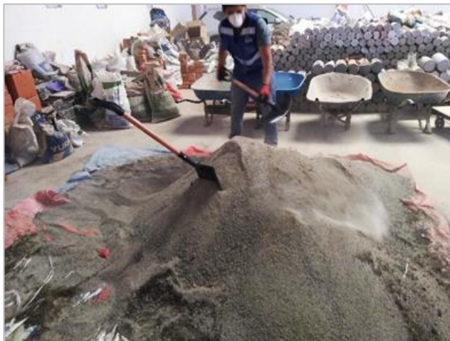
Figura 3.2. Homogenización del agregado fino de la cantera “La Poderosa”
