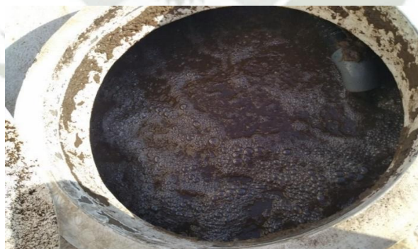
Figura 24. Tratamiento Biológico por Aireación – observaciones diarias
