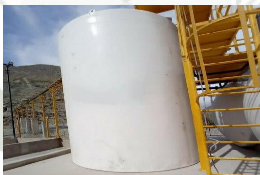
Figura 3. Tanque de ecualización
