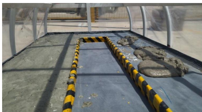
Figura 7. Lodo residual con cal en el desecador solar
