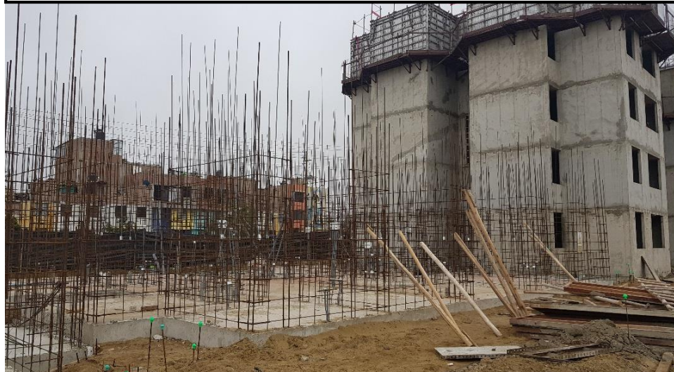
Platea de Cimentación y malla electro soldada
