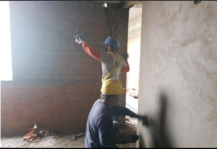
Tarrajeo de Muro Fuente: Propia
