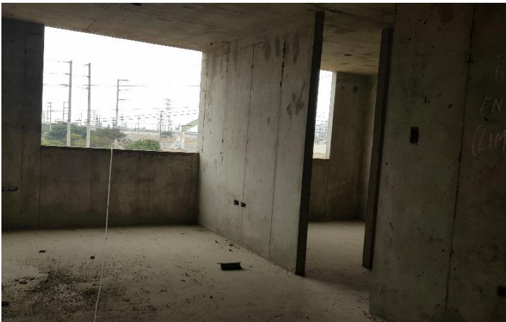
Acabado Cara Vista Fuente: Propia
