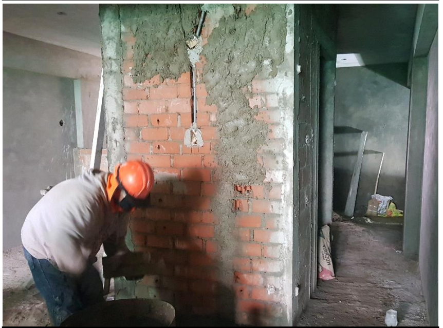
Tarrajeo de Muro Fuente: Propia
