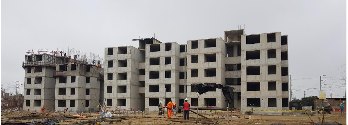
Fachada Principal-Muros de Ductilidad Limitada Fuente: Propia
