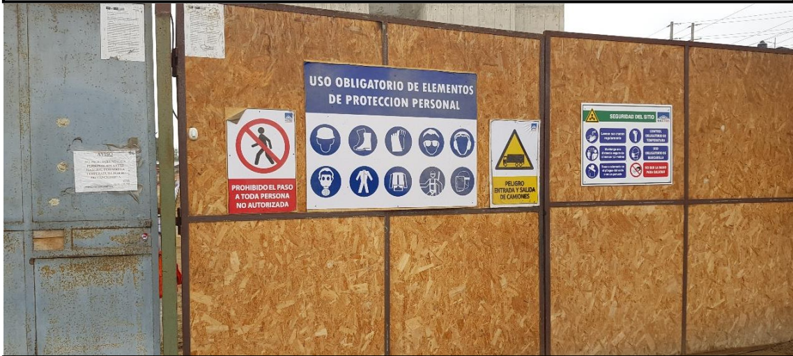
Ingreso a Obra, prevención Covid-19 Fuente: Propia
