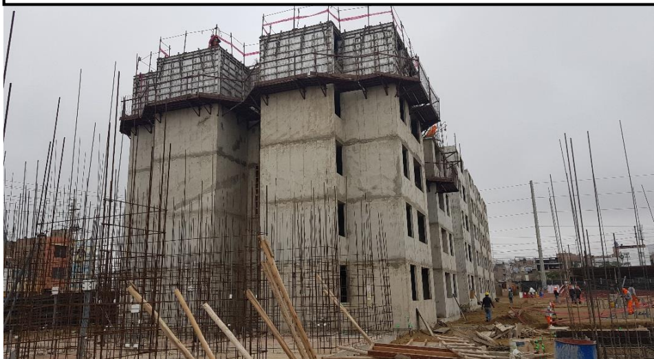
Encofrado de Muros de Ductilidad Limitada
