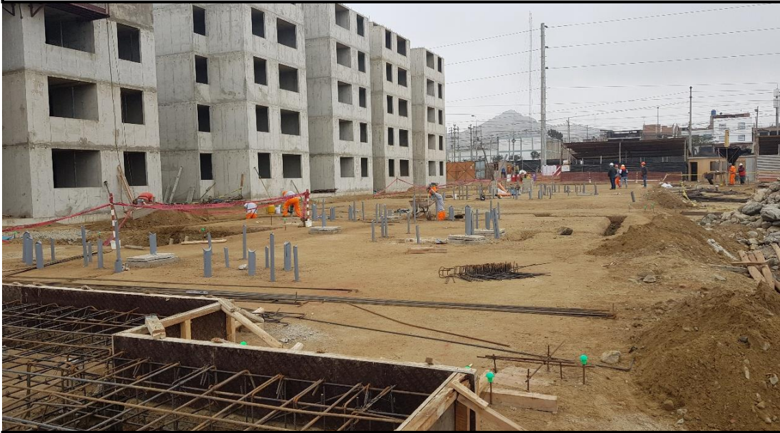
Armado de Platea de Cimentación Fuente: Propia
