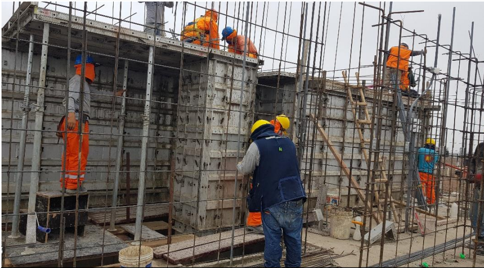
Encofrado de Muros de Ductilidad Limitada
