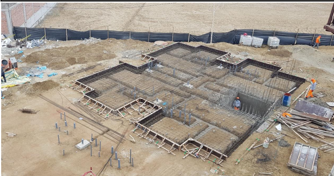
Armado de Platea de Cimentación Fuente: Propia
