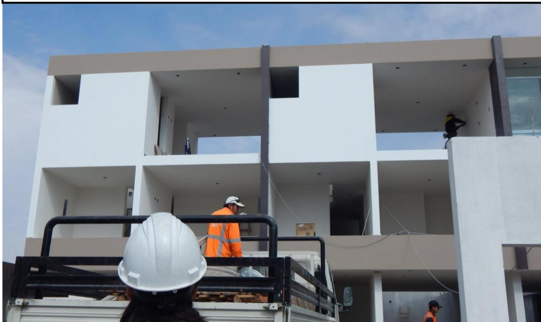
Fachada de Albañilería Confinada Fuente: Propia
