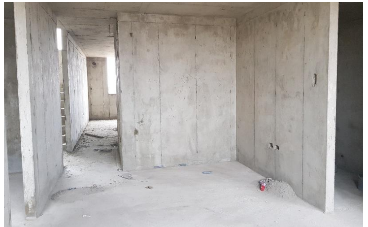
Acabado Cara Vista Fuente: Propia
