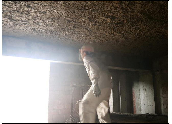
Tarrajeo de Losa Aligerada Fuente: Propia
