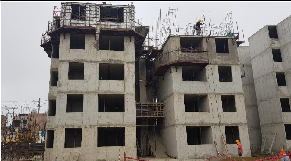
Encofrado de Muros de Ductilidad Limitada
