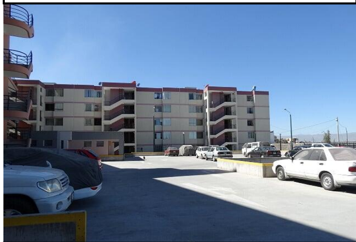
Estacionamiento en área libre- Huaranguillo Fuente: Propia
