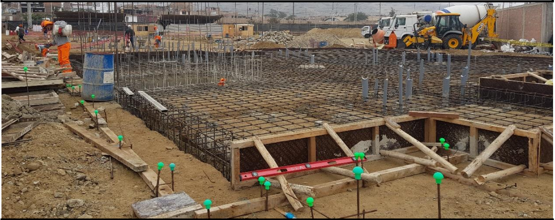
Armado de Platea de Cimentación
