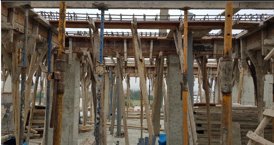
Vaciado de Vigas Fuente: Propia
