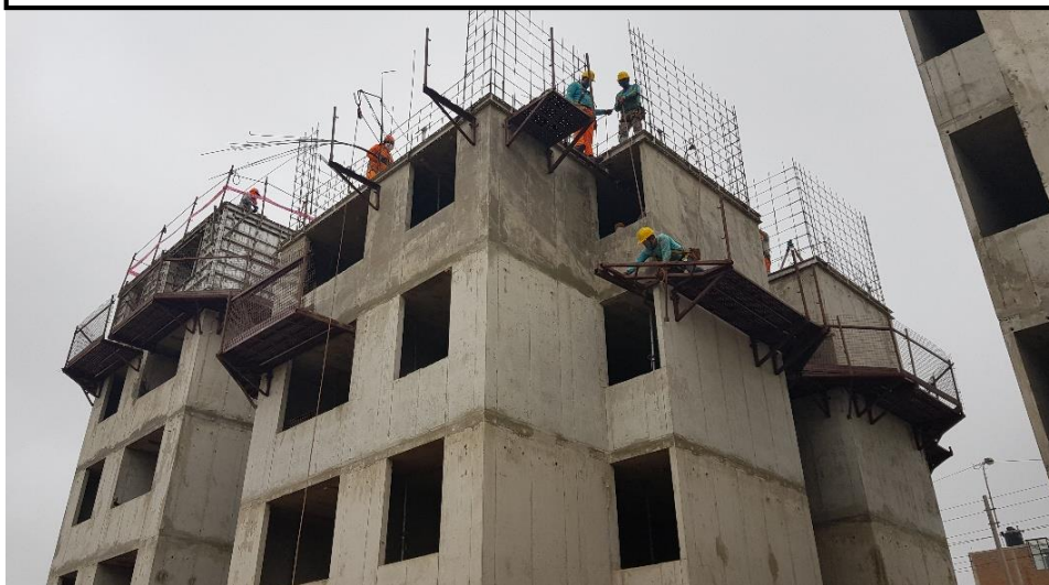
Armado de Muros de Ductilidad Limitada
