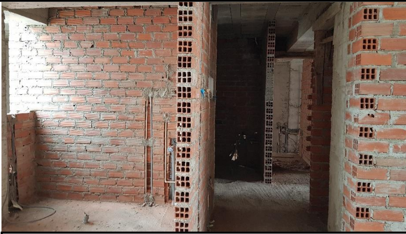
Muros de Albañilería Confinada Fuente: Propia
