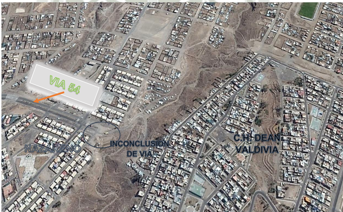
Figura 1.2 Falta de continuidad en la vía 54 por presencia de Torrentera
