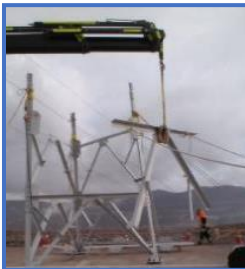
Figura 3.17 Montaje de Estructuras
