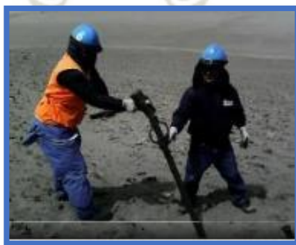
Figura 4.6 Fijación de cáncamos a terreno
