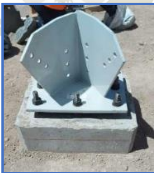
Figura 3.13 Instalación de la placa base
