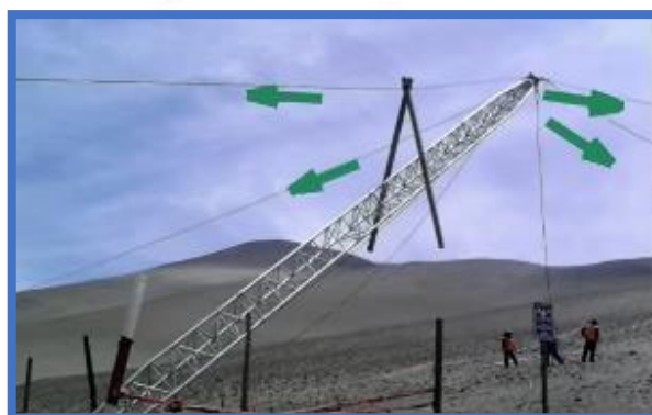
Figura 4.8 Proceso de instalación de pluma de izaje
