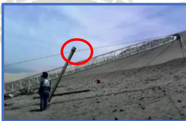
Figura 4.7 Colocación de los listones de madera
