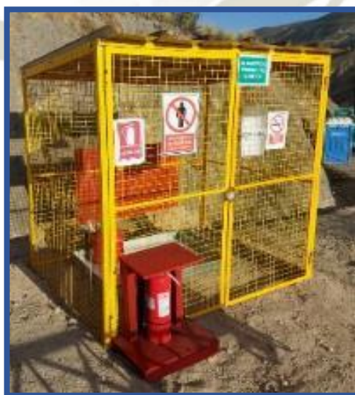
Figura 3.8 Almacén de productos químicos
