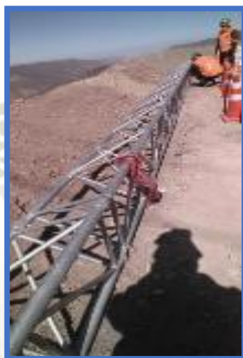
Figura 4.5 Armado de pluma de izaje en piso
