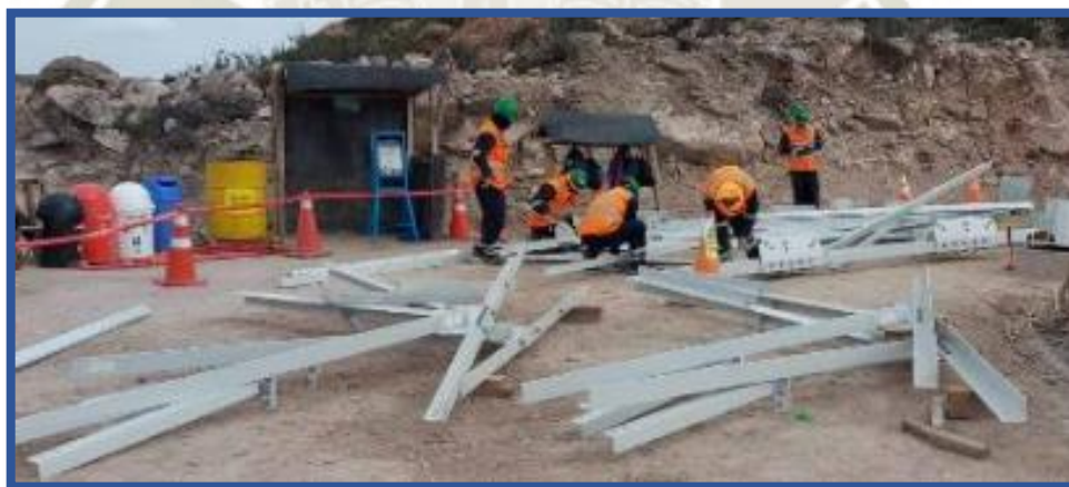
Figura 3.14 Pre-ensamble en piso de las estructuras metálicas
