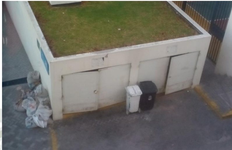
Figura N° 19: Almacenamiento temporal de los residuos no peligrosos
