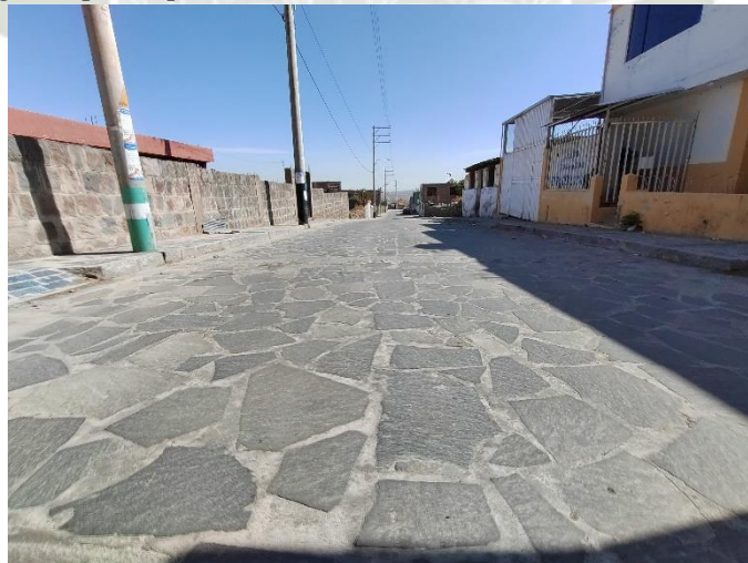
Figura 58 Fotografía del ingreso principal
